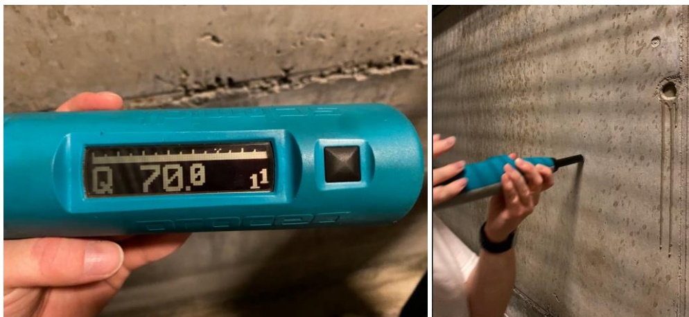
Fig. 14: Betonghammer, fra befaring i Pirbadet 4. mai
