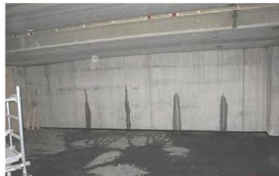
Garasjevegg fastholdt mot bunnplate
