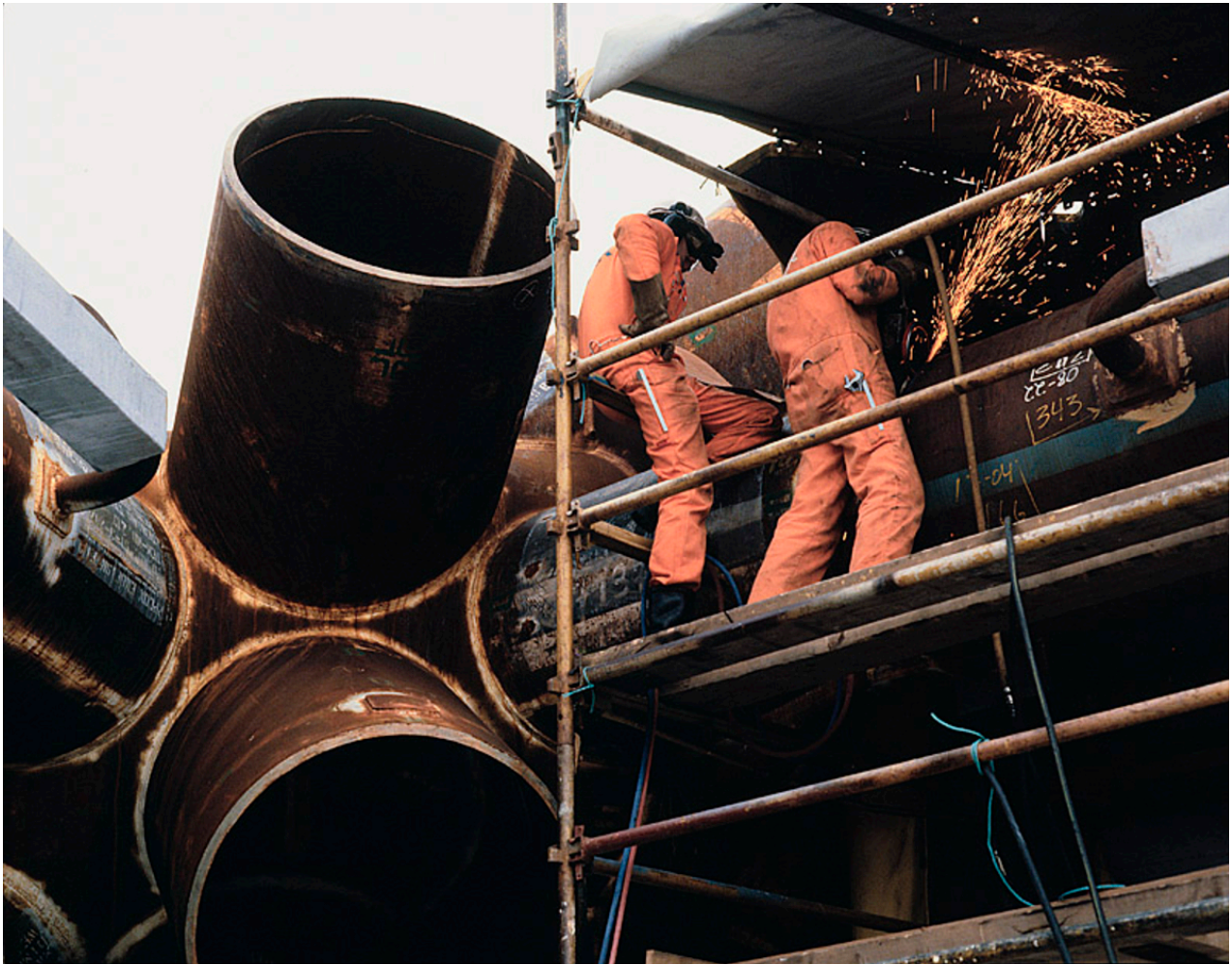
Figur 11 Illustrer sveising av rørknutepunkt for jackets på Aker Verdal. Bildet hentet fra (4)
