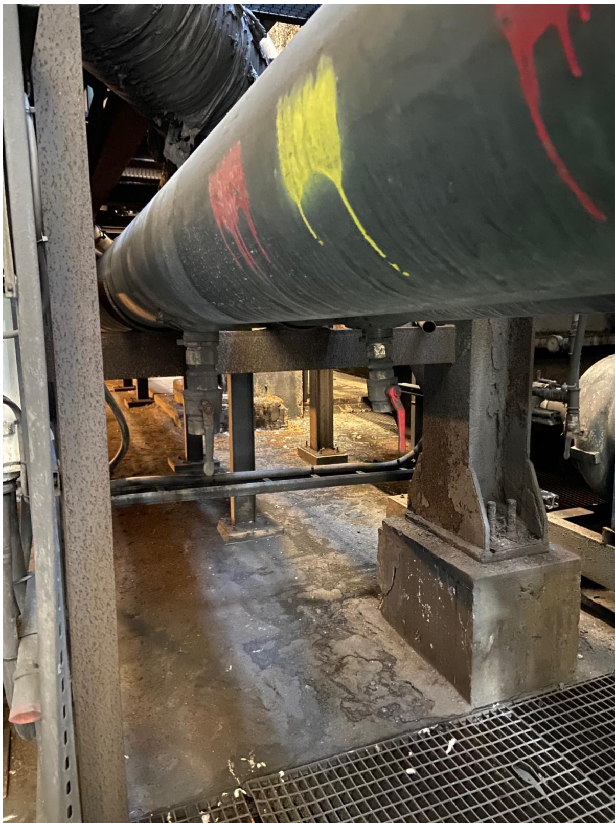
Figur 8 viser kranuttak på to av samlerørene, her åpnes kranen for å ta ut en prøve.
