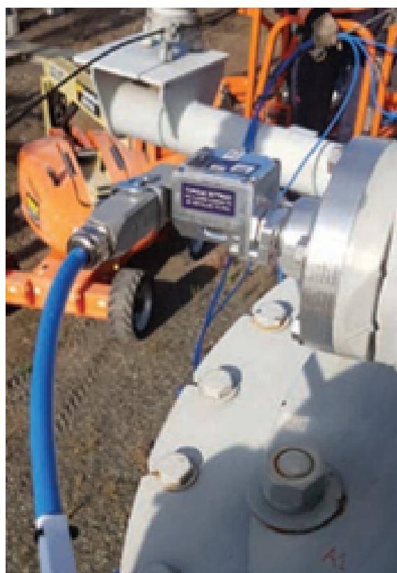
Figur 4.12: Sensor på gjennomføring. TOTUS system
