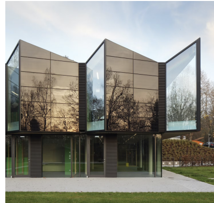
(d) BIPV in facades, in Marburg, Germany [23].
