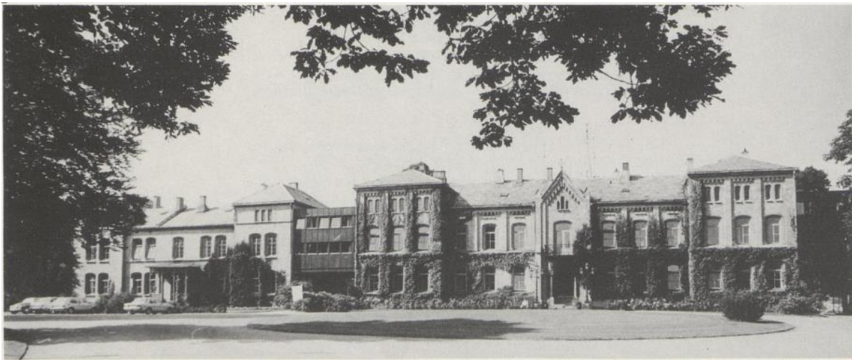
Bilde 4: «De utvide administrasjonsbygg med de kobber-kledte mellombyggene som binder det sammen med de gamle A-fløyene». Fotograf og år ukjent, men en gang etter 1974 begrunn av dateringen på mellombyggene.
