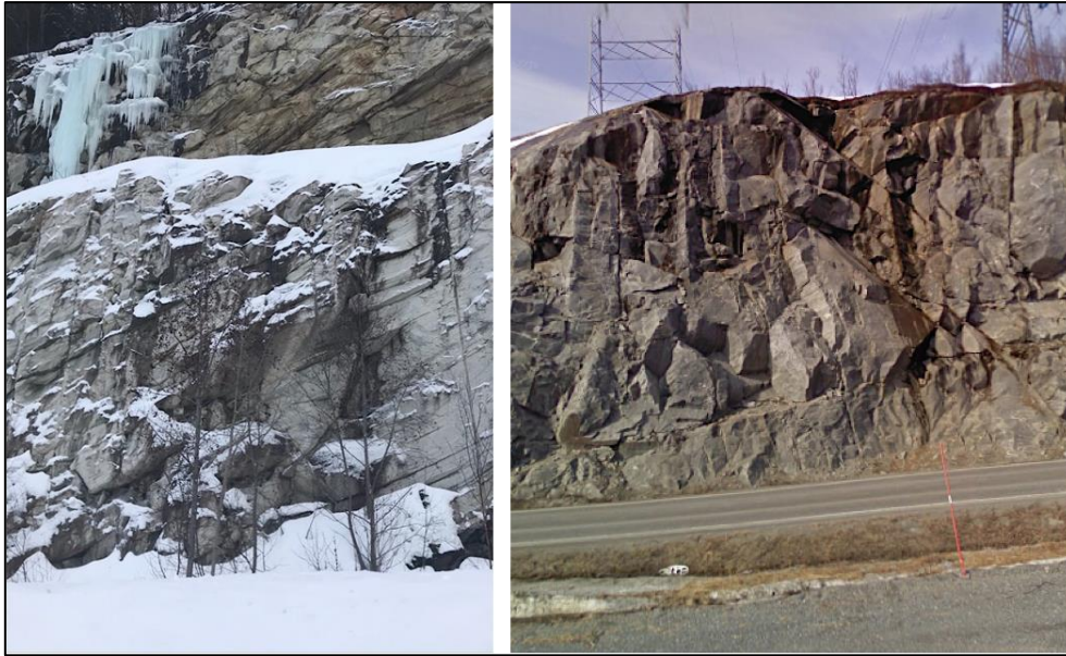
Figur 8 - Foto av nærliggende veiskjæringer
