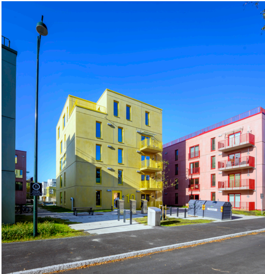
Figur 26: Den midtre bygningen, sett fra øst (Trym.no, u.d.).
