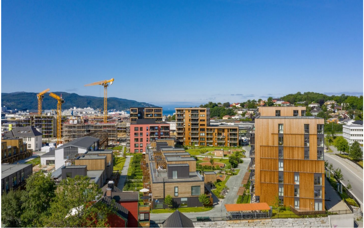
Figur 11: Veidekke sitt prosjekt på Lilleby sett fra øst (Nyelilleby.no, u.d.-b).
