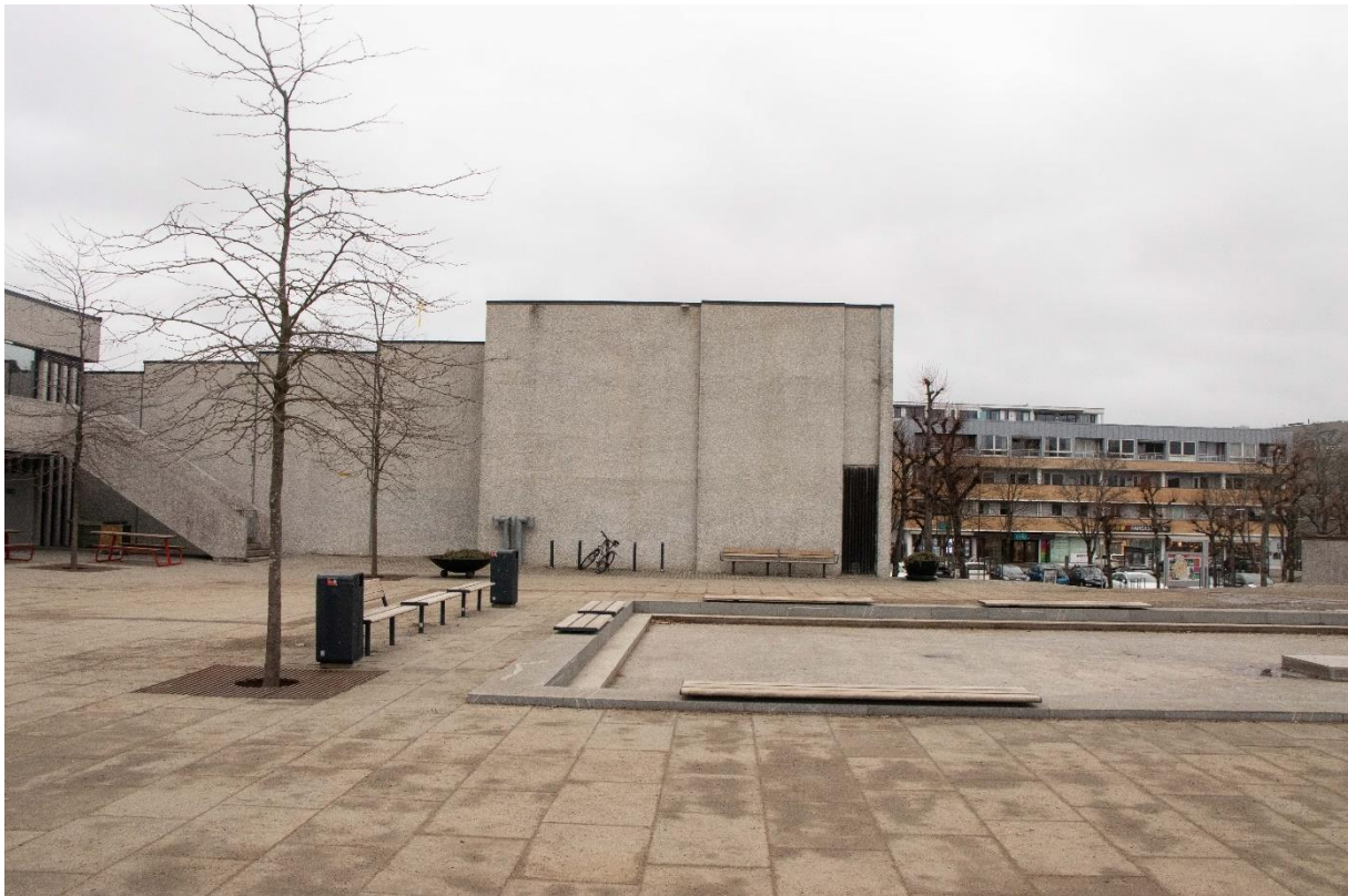
Bilde 17: Ås rådhus ble bygget med torg/ borggård.
