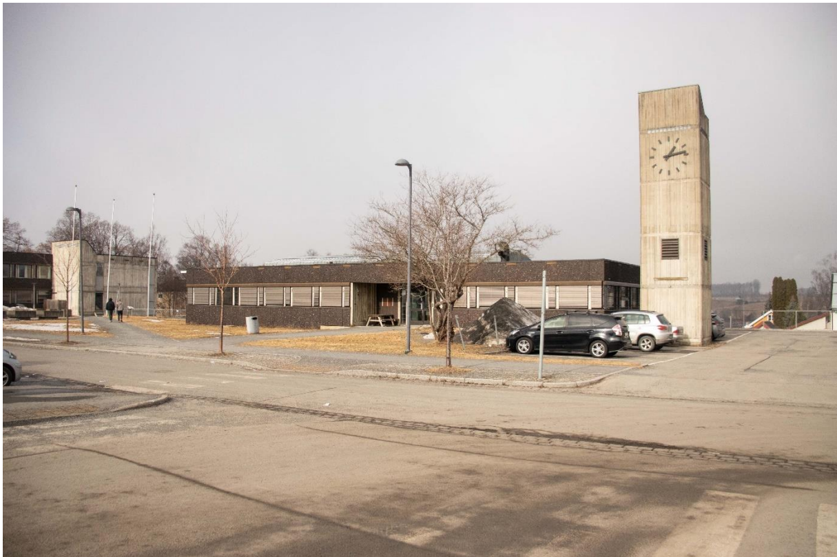
Bilde 33: Helsebygget med slangetårn
