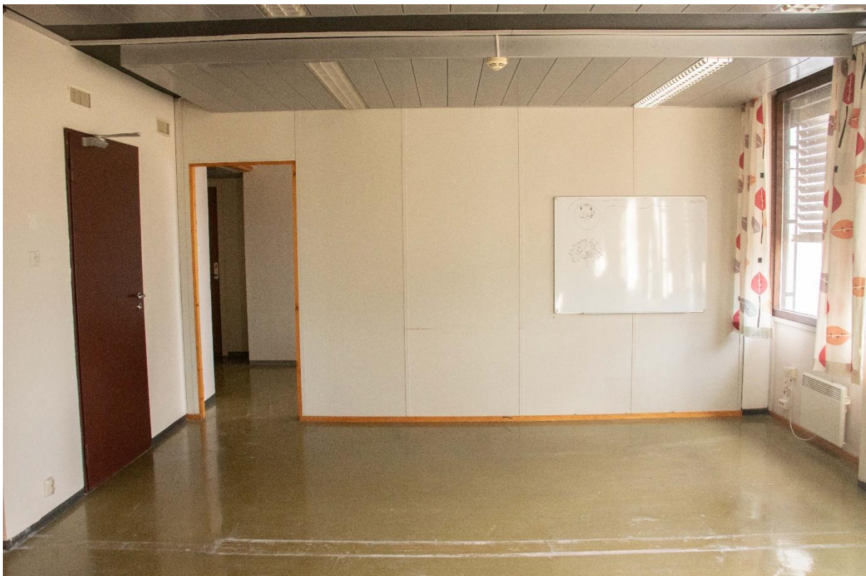
Bilde 45: Spor etter vegg i linoleumsbelegg i første etasje.
