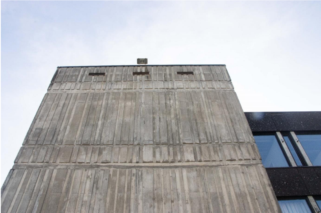
Bilde 34: Trappetårn i betong
