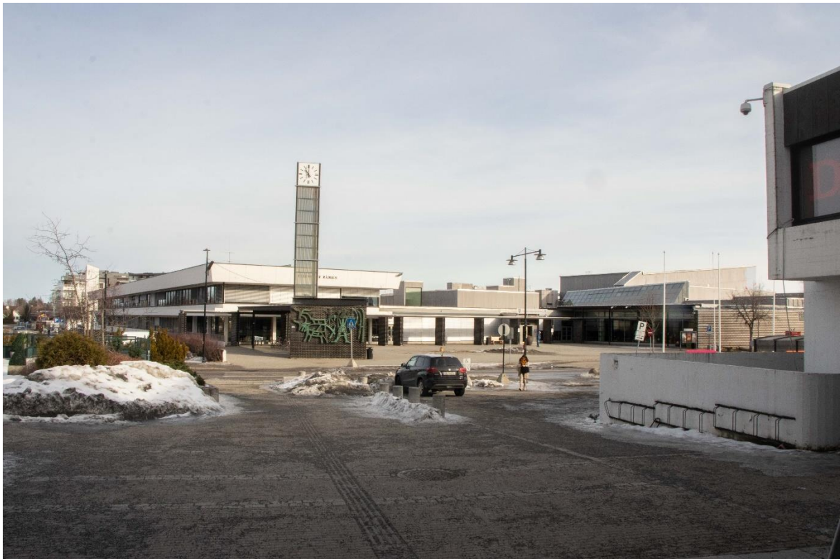
Bilde 24: Ullensaker rådhus med nyere kulturhus (til høyre i bilde).
