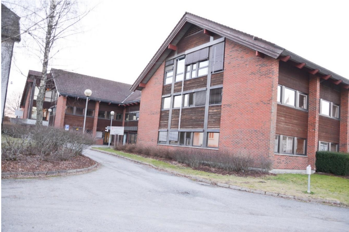
Bilde 6: Spydeberg kommunehus fra 1980-tallet, bygget på totalentreprise av firmaet Totalprosjekt A/S. 114
