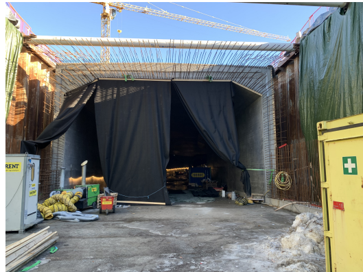
b) Kulvert - rektangulært tverrsnitt
