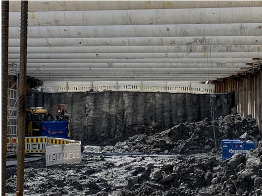
Figur 2.3 – 8 meter utgraving gjennom etablert KS-stabilisering inne i byggegroppen.
