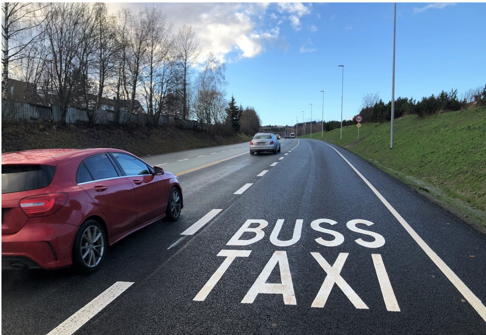
Figur 2.5: Nyetablert kollektivfelt sett fra Bjørndalsbrua i vestgående retning (Miljøpakken, u.å.-c).
