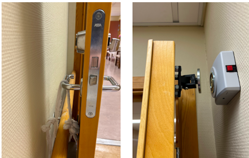
Figur 6.5: Dørvrider som er bundet fast med tøyestykke til venstre og en defekt dørholdemagnet til høyre.
