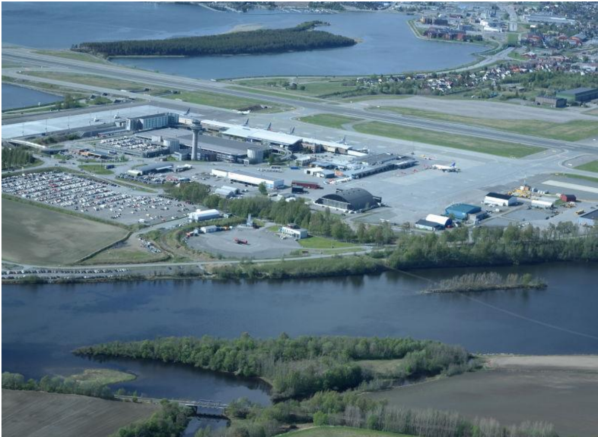
Figur 15. Her vises et bilde av det meste av bygningsmassen på Trondheim lufthavn samt deler av flystripa. Av forskjellige typer bygninger kan man blant her se det store terminalbygget, flytårnet, det store parkeringshuset, og forskjellige typer haller og driftsbygg. Hentet fra (bbcairport, u. d.)
