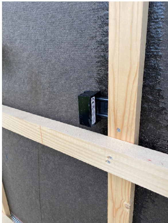
Figur 3.14: Bilde av hvordan sensorene er plassert i luftespalter i fasadene i Norgeshus (Gullbrekken, Kvande og Time, 2021).
