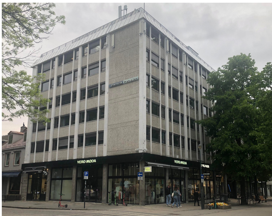
Figur 4.12: Bilde av Nordre gate 12 sett fra krysset mellom Nordre gate og Dronningens gate (E.C.Dahls Eiendom, 2022b).
