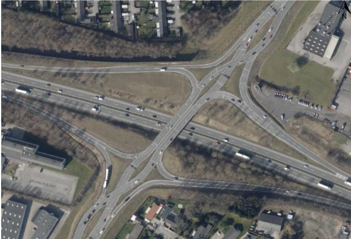
Figur 18: Flyfoto fra Odense som viser krysset etter ombygging til DDI (Det Kgl. Bibliotek, 2022)
