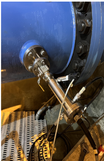
Figur 3.2: Målesonden etter at den er blitt montert
