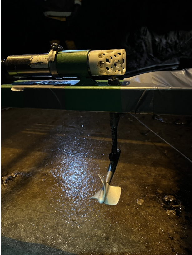
Figur 3.5: Nærmere bilde av målerammen montert i avløpet
