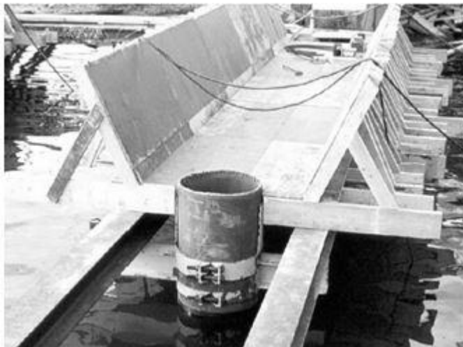
Figur 4 Illustrasjon som viser hvordan en typisk bjelkeforskaling utføres, hentet fra ref. [5]
