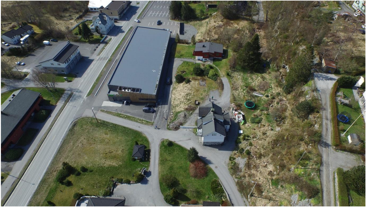
Bilde tatt med drone fra øst
