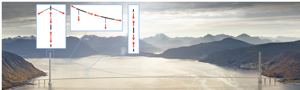
Figur 2.4: Trykk- og strekkrefter i konstruksjonen
