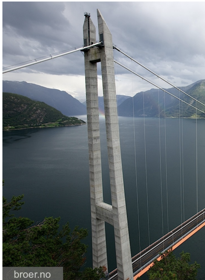
Figur 2.5: Eksisterende brutårn på Hardangerbrua. Foto: broer.no
