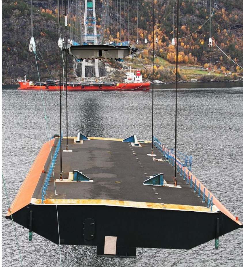
Figur 2.7: Brukasse Hardangerbrua. Foto: tu.no
