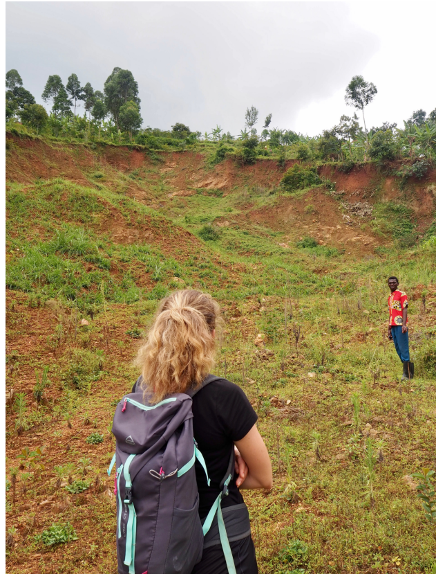
Figur 5: Jordskredet som gikk i Manafwa i 2019 er fremdeles synlig i terrenget. Foto: Privat
