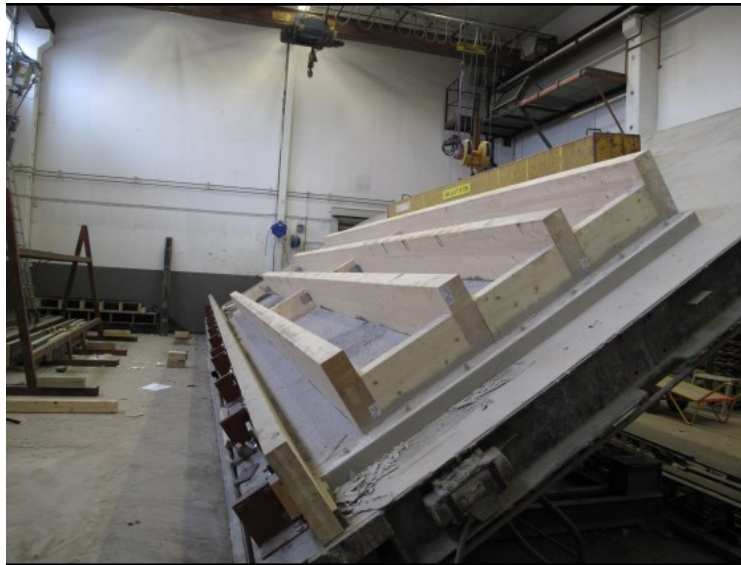
Figur 4-5: TCC som har blitt støpt i forskalingsform på hode (Crocetti, 2018).
