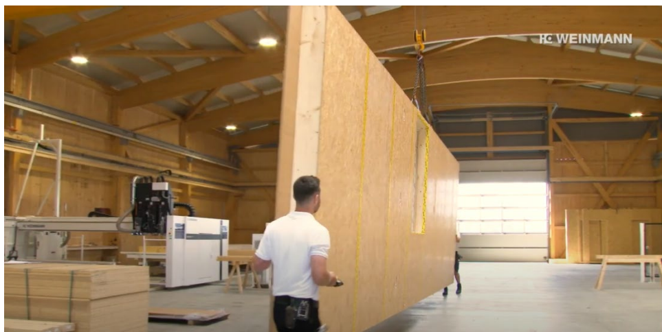
Figur 38 Forflytting av ferdige elementer med takheis med skinnesystem.
