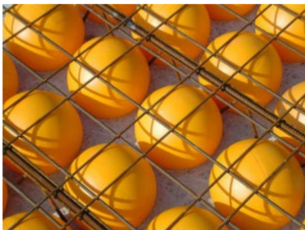
Figur 2: Bubbledeck med armering og plastkuler for vektbesparelse
