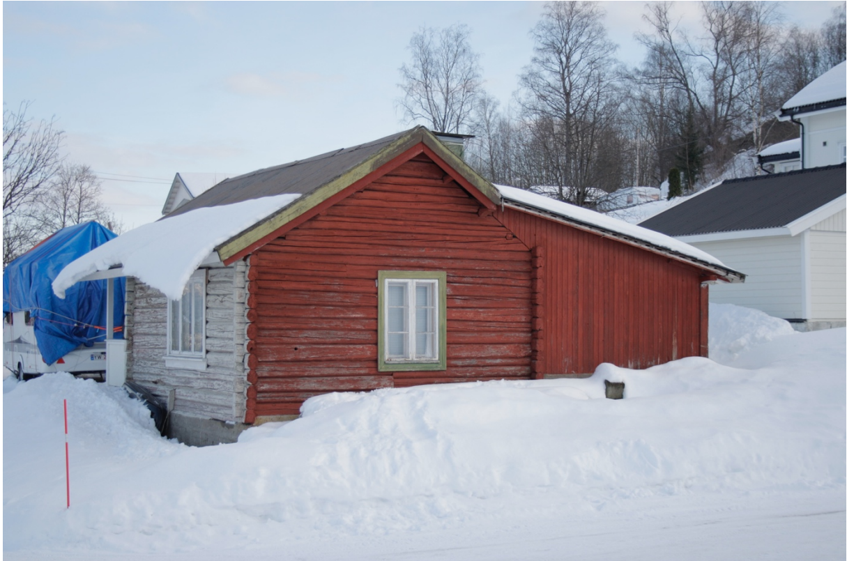
Figur 16: Bygg 5, laftet hytte. Foto: Sindre Kåseth.
