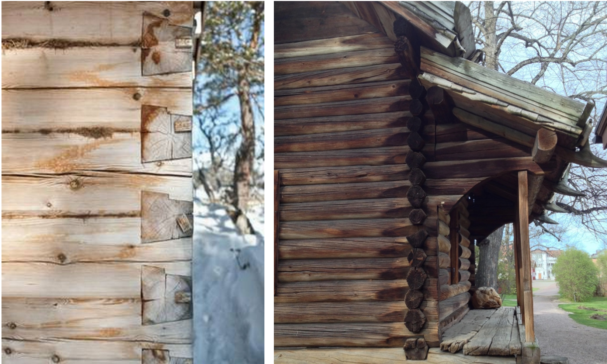
Figur 2: Eksempelbilder på ulike lafteteknikker. Til venstre: Sinklaft, Foto: Foto: Pasi Aalto. Til høyre: Findalslaft, Foto: Kai Johansen.
