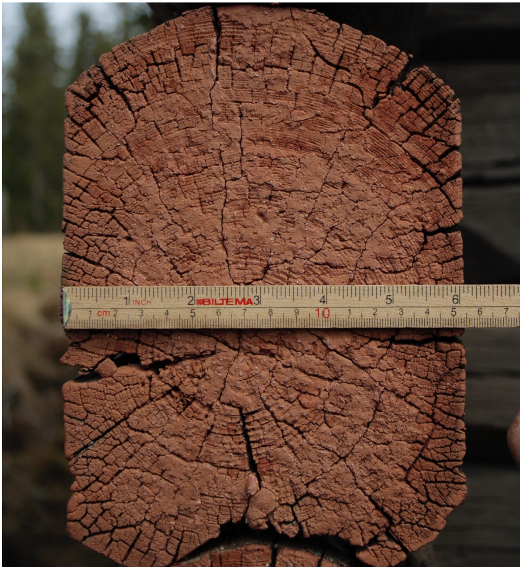
Figur 8: Eksempel på måling av tykkelse fra bygg 3. Foto: Sindre Kåseth.
