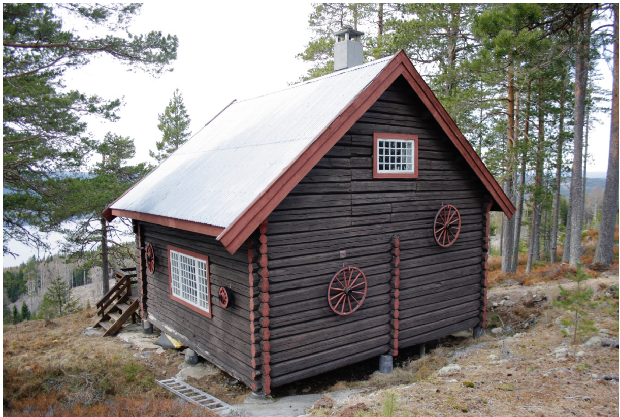
Figur 14: Bygg 3, laftet hytte. Foto: Sindre Kåseth.
