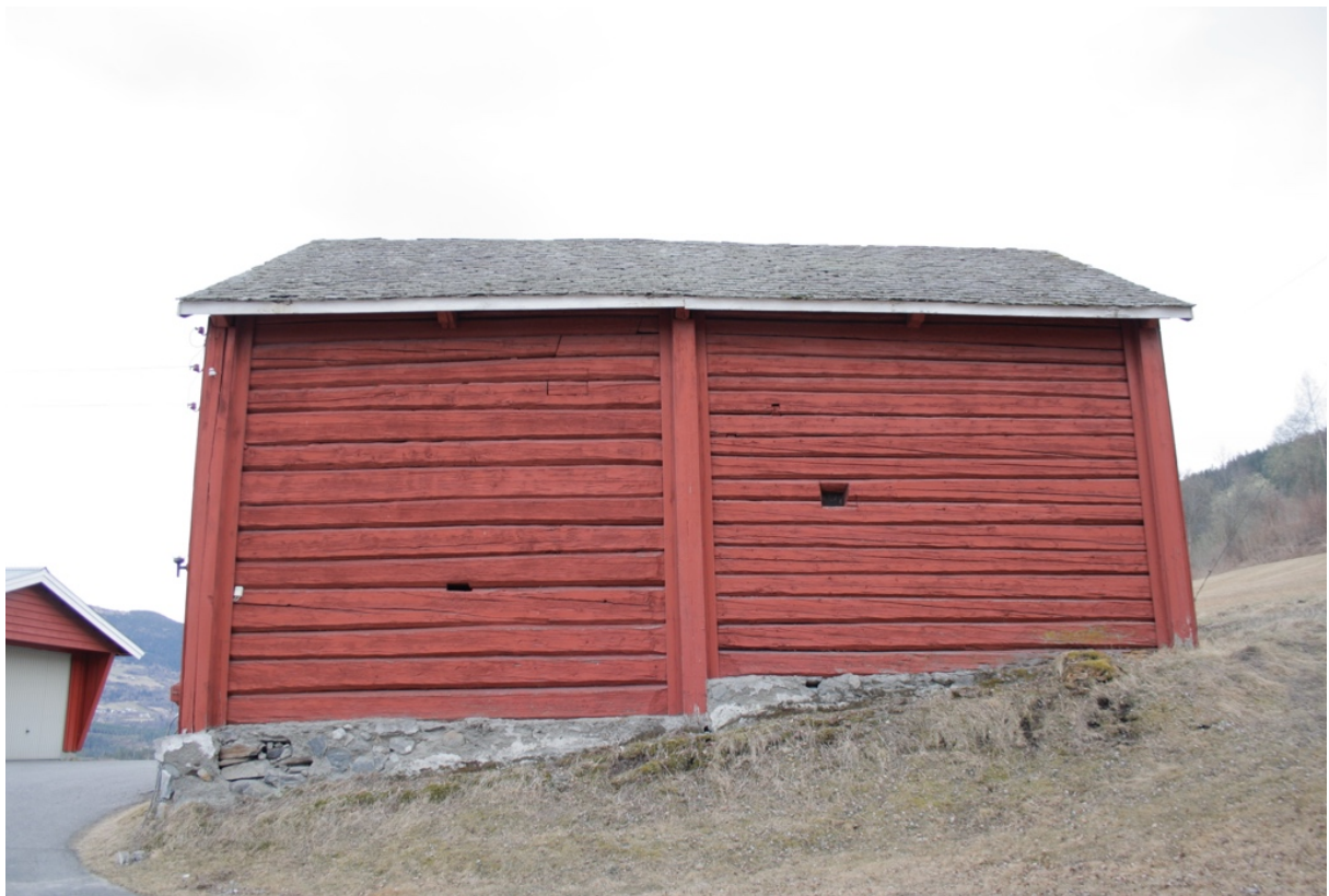
Figur 13: Bygg 2, laftet stabbur. Foto: Sindre Kåseth.
