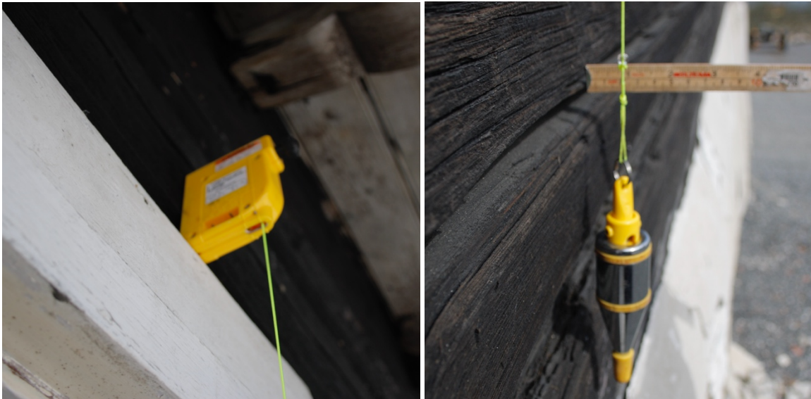
Figur 11: Eksempel måling av loddavvik fra bygg 1. Foto: Sindre Kåseth.
