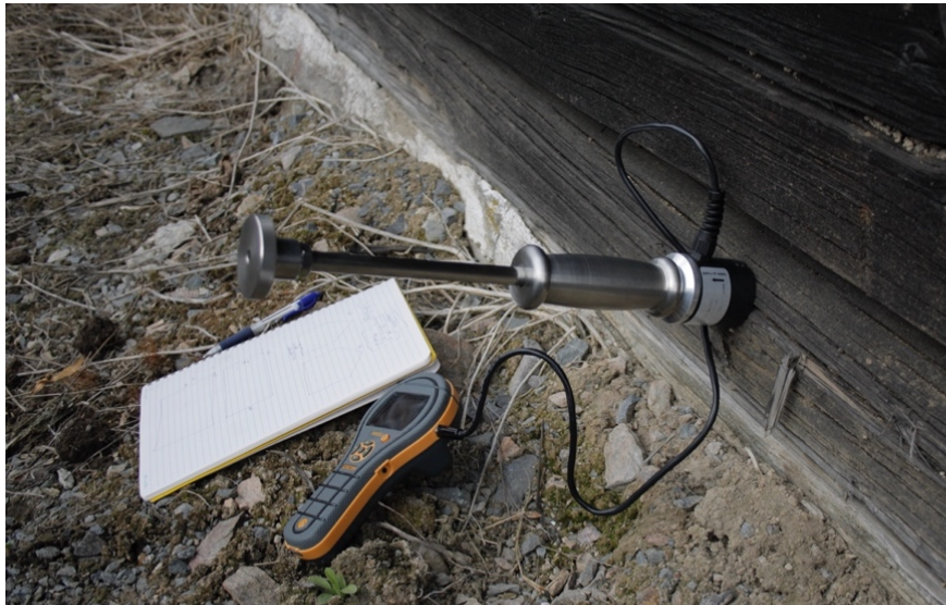
Figur 9: Eksempel på fuktmåling med Protimeter MMS2 på bunnstokk fra bygg 1. Foto: Sindre Kåseth.
