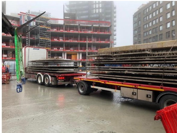
Figur 6: Leveranse av plattendekke (Egenprodusert)
