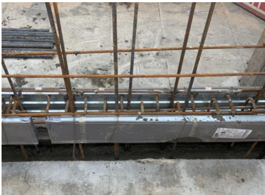
Figur 28: Hektisk punkt ved montering av skjøtearmeringskassetter (Egenprodusert)
