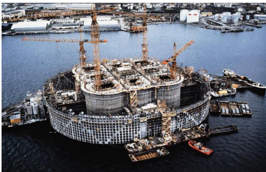
Figur 11: Glidestøp av Ekofisk 2/4T (Kvendseth, 1989, s. 73)
