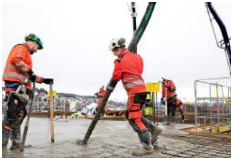
Figur 7: Påstøp på plattendekke (Deraas, Boye, & Miland, 2019)
