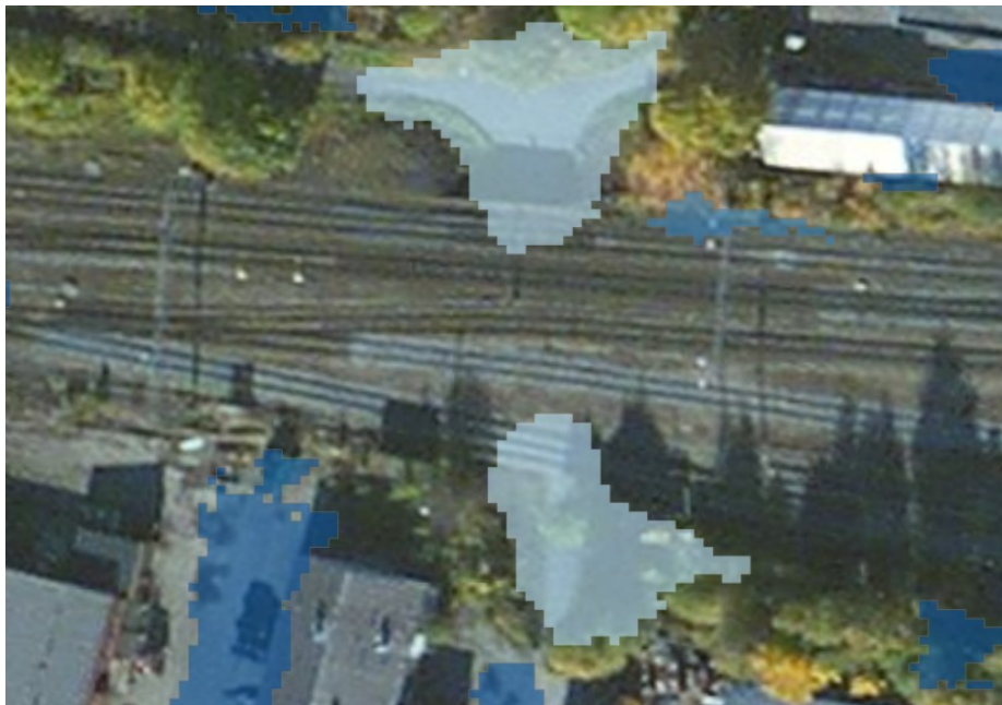
Figur 70: Utsnitt over to forsenkninger lokalisert ved inn- og utgang i en undergang under jernbanen
