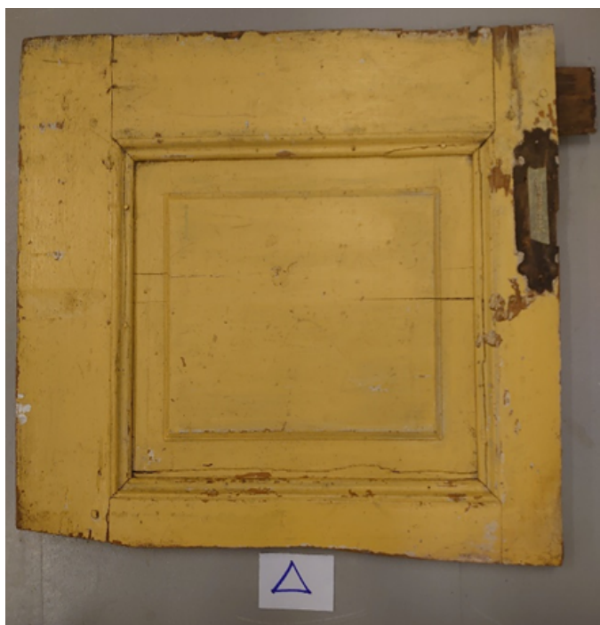
BILDE 10 – DØRA SETT FRA HENGSELSIDE/FRAMSIDE
