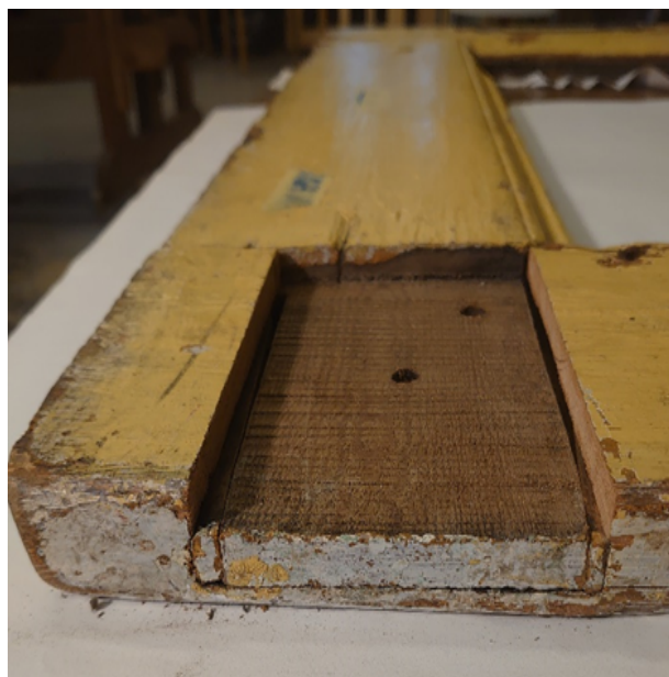
BILDE 74 – TAPPFORBINDELSE. INNV. TAPPHULL
