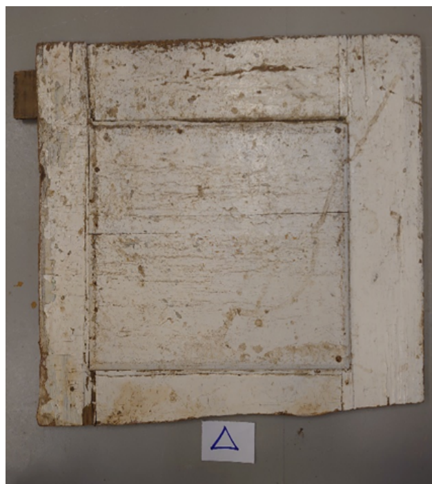
BILDE 11 – DØRA SETT FRA BAKSIDE
