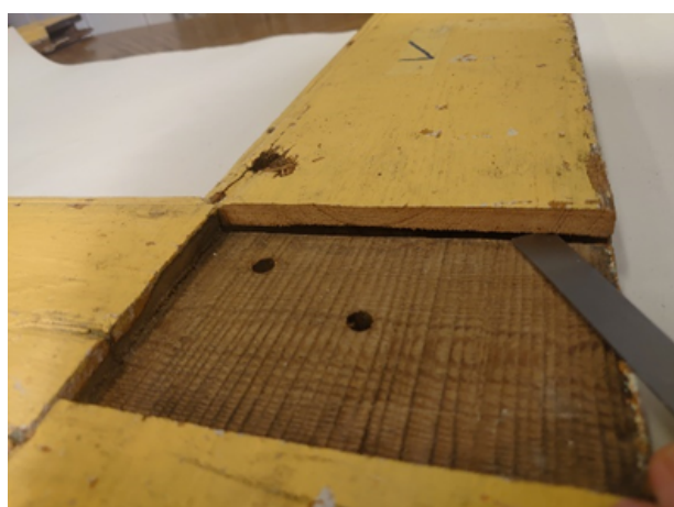
BILDE 78 – MER NØYAKTIG MOT INNGANG TAPPHULL
