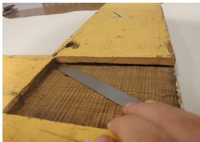
BILDE 77 – DET ER MINDRE KLARING UT MOT KANTENE
