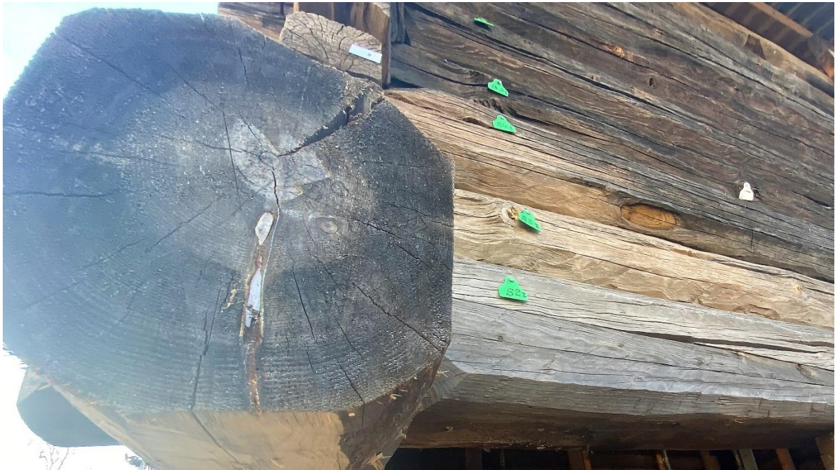
Figur 17 Øremerker festet til vegg med bokstav og nummer Foto: Jortveit/Ryen
