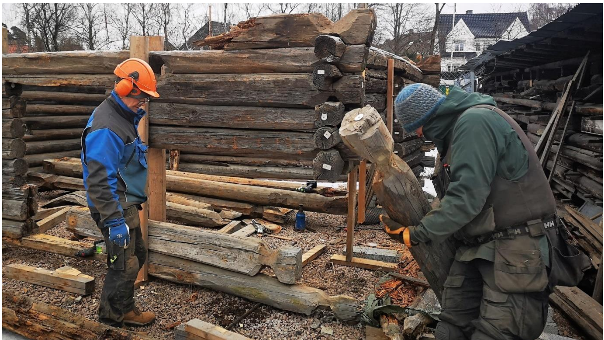
Figur 25 vegg er plukket ned og det stables om Foto: Jortveit/Ryen
