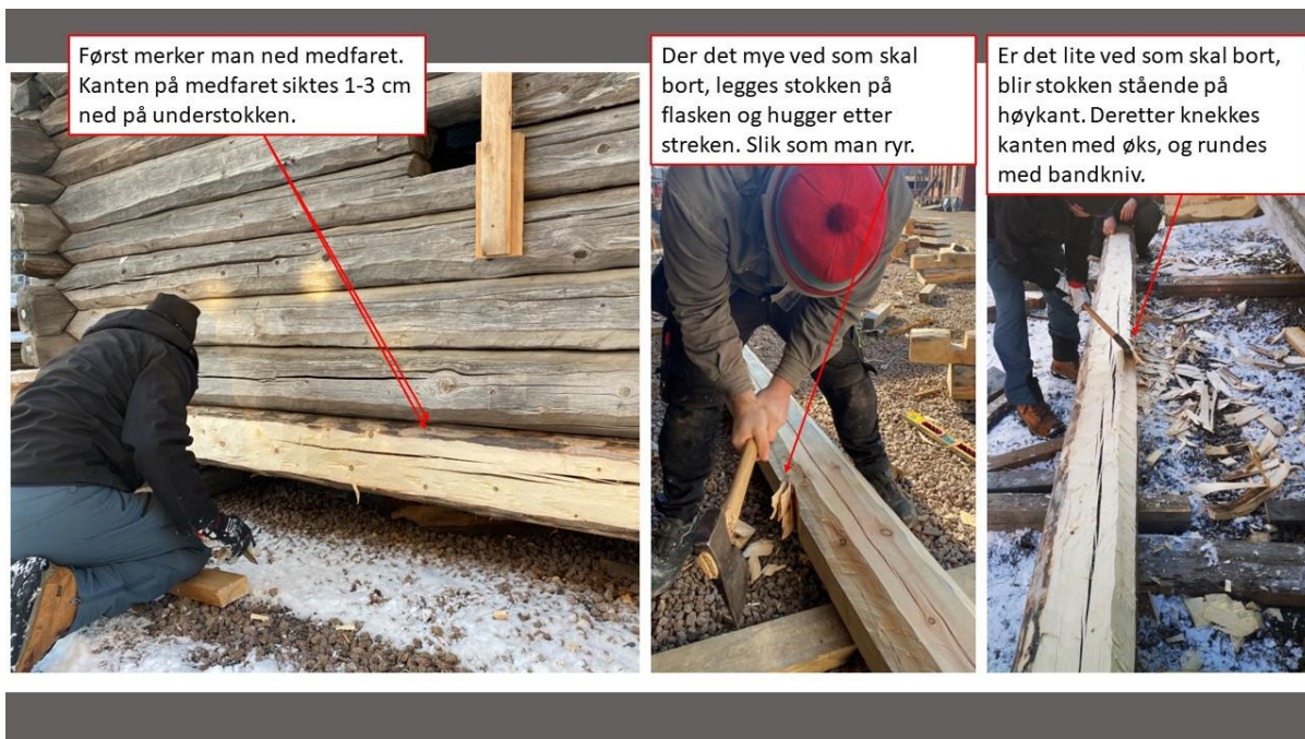
Figur 47 Framgangsmåte på sikting, streking og hugging Illustrasjon: Ryen, Foto: Jortveit/Ryen
