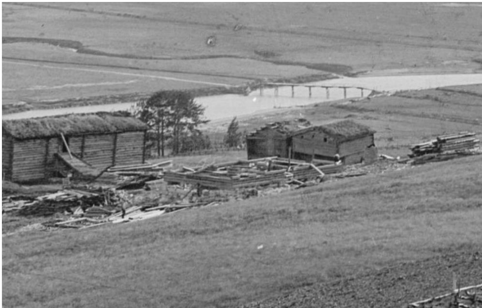
82. Bilete syner tømringa av våningshuset på Hovauk. her kan ein sjå at dei er kome til 4 omfar. to personar står å tømmer mens to personar står å truleg og arbeidar med tømmeret (Rekstad j. 1897).
