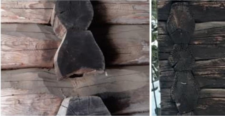
35. Laftehovuder på Molstadkvernbygningen, ei blanding mellom hesthugu, rundt hesthugu og hjart-nov. (foto;Høgnes)
