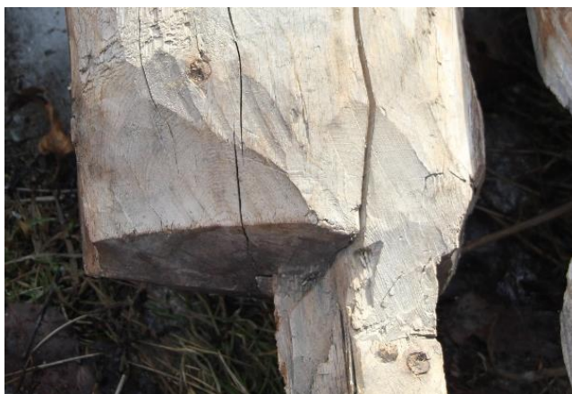
80. Eksempel på at kinningane på oppløftet går lengre ned enn møte for nedløftet.
