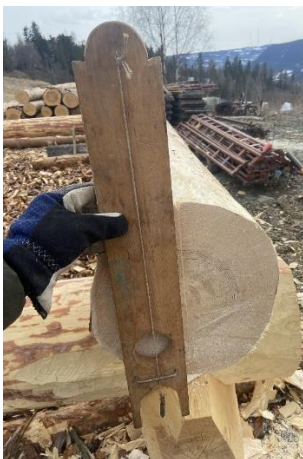
20. Lodding av enden på novskallen, til hjelp for å forme novskalle. (Foto: Aabol)
