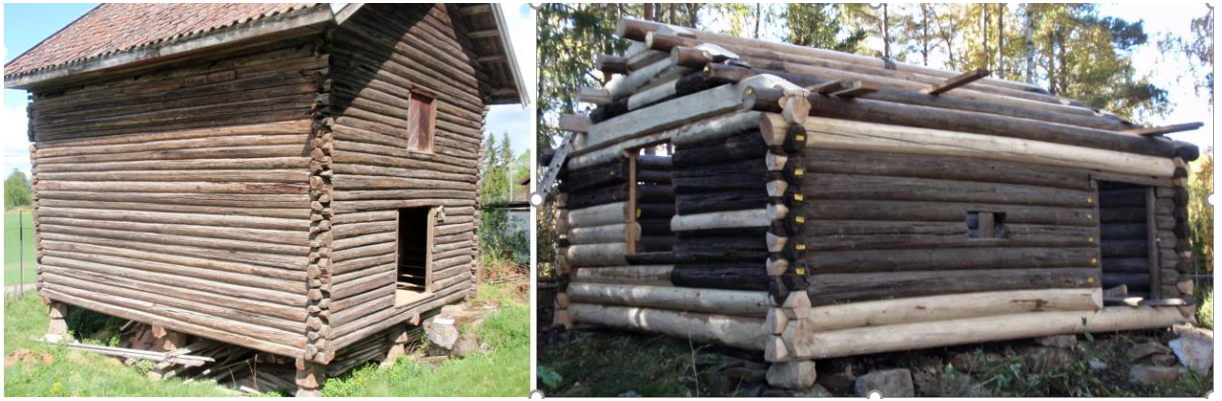
36. Telthuset på Granavollen og smie på Kjos, lokale 1700-tals bygningar (foto: Høgnes)
