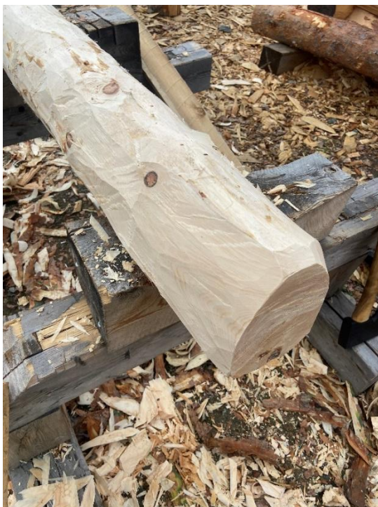
24. Halsing og forming av novskalle. (Foto: Aabol)
