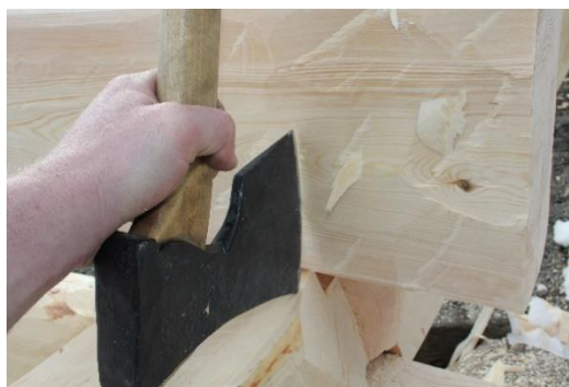
92. Lodde opp toppen av kinningane på nedlaftet. (Foto: Selsjord)
