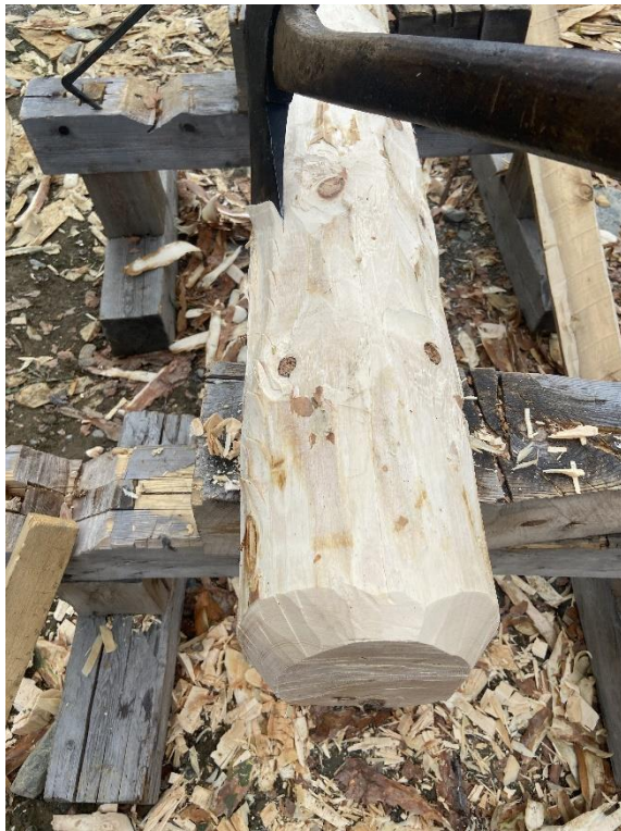
23. Halsing og forming av novskalle. (Foto: Aabol)
