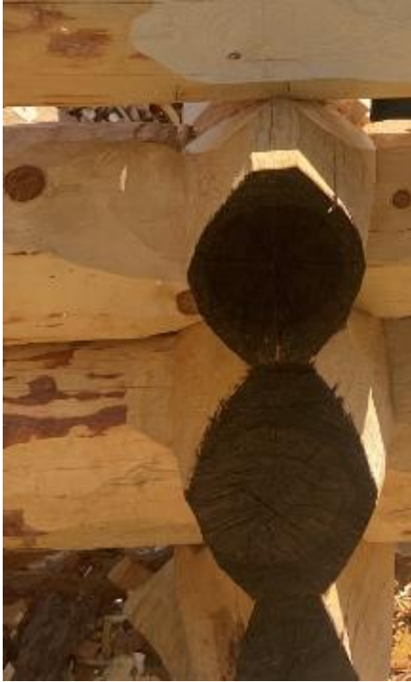
30. Novskallane er sett inn med tjøre. Prøvelafte – Aabol. (Foto: Aabol)
