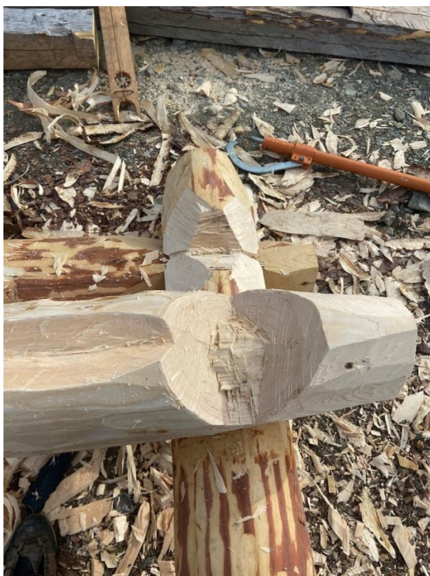
27. Stokken ligg støtt og i ro med nedhogget i ryggen. Legg merke til at médraget svingar noko inn i enden. dette kjem av at méden startar inne på kinninga i oppsåta. (Foto: Aabol)
