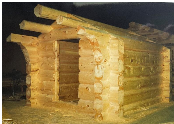
79. Bua som var tømra av rått tømmer i 1995. (Foto: Geir Groven)
