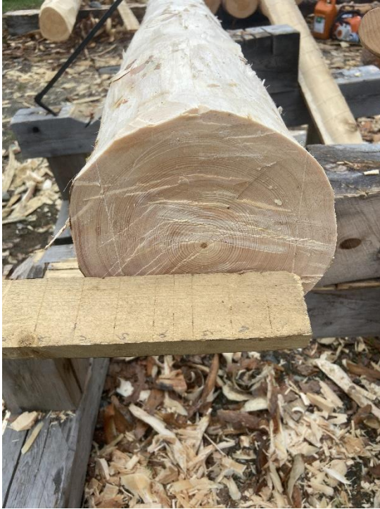
21. Breiddeavgrensing av novskalle. (Foto: Aabol)
