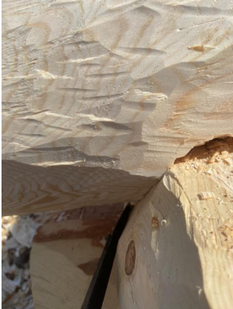
29. Mauren rissar – mauren kviler sida mot kinninga i oppsåta og rissar spor for hogging i underhogget. (Foto: Aabol)
