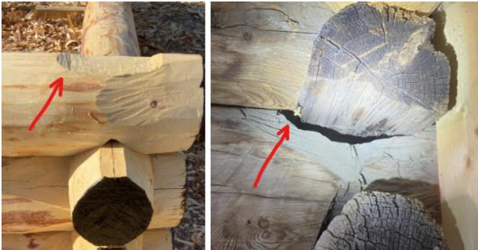
25. Nytt og gammelt nedhogg i ryggen på stokken (prøvelaft og ref.bygg Aabol) (Foto: Aabol)
