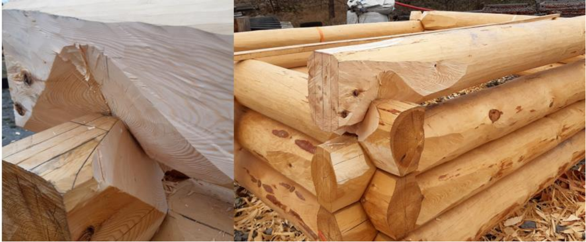
61 og 62. "Postordrelaftet" la seg fint på, så det var ikkje mykje justering før ein kunne médra.(Foto;Høgnes)
