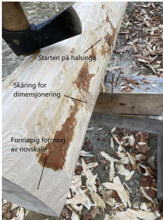
22. Prosess – halsing og forming av novskalle. (Foto: Aabol)
