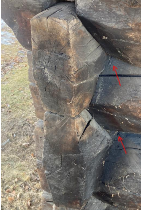
19. Verktøyspor som syner forming av novskalle, Handeloftet. (Foto: Aabol)
