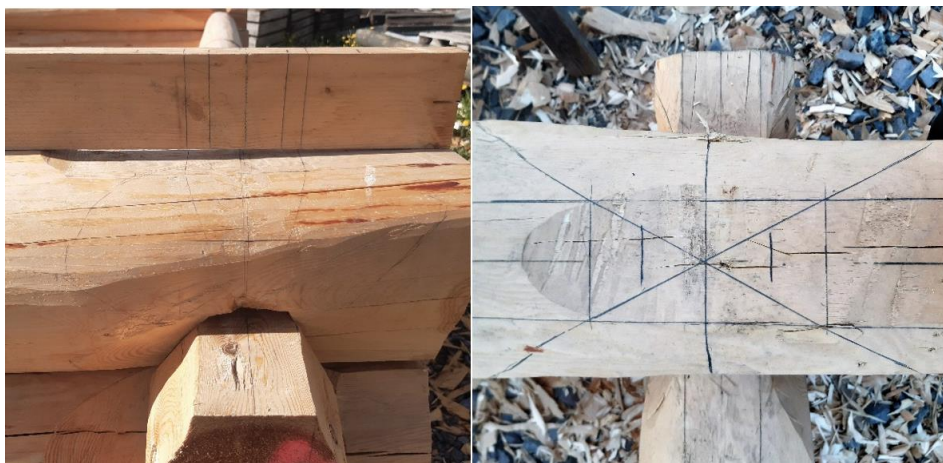
50 og 51. Oppmåling og merking av opplft før hogging, merka etter faste mål på malen eg bruka på flatinga på ryggen (Foto:Høgnes.)
