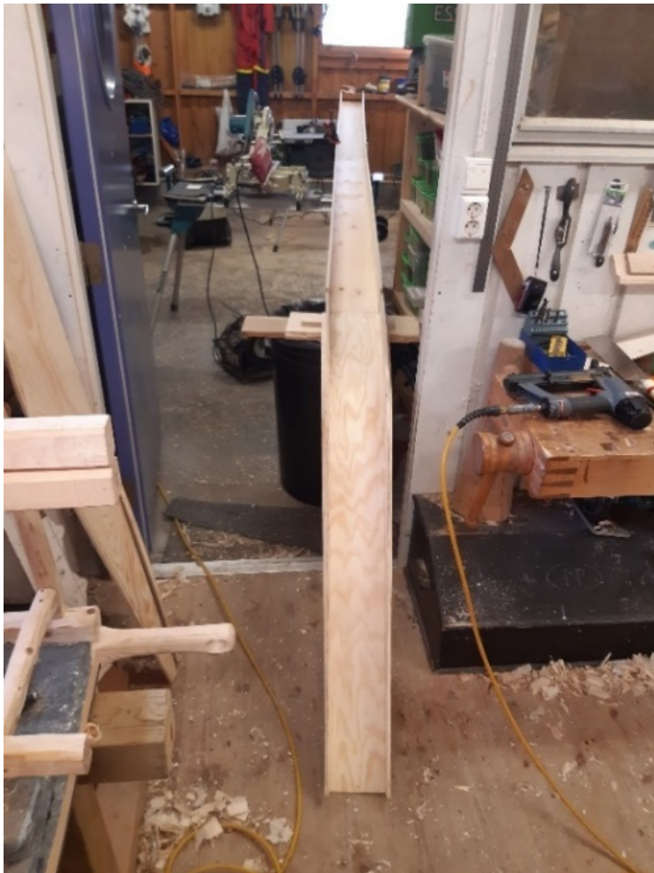
Figur 61 Rennedeler er prefabrickert, og prøvemontert i verksted. Foto: Morten Pedersen
