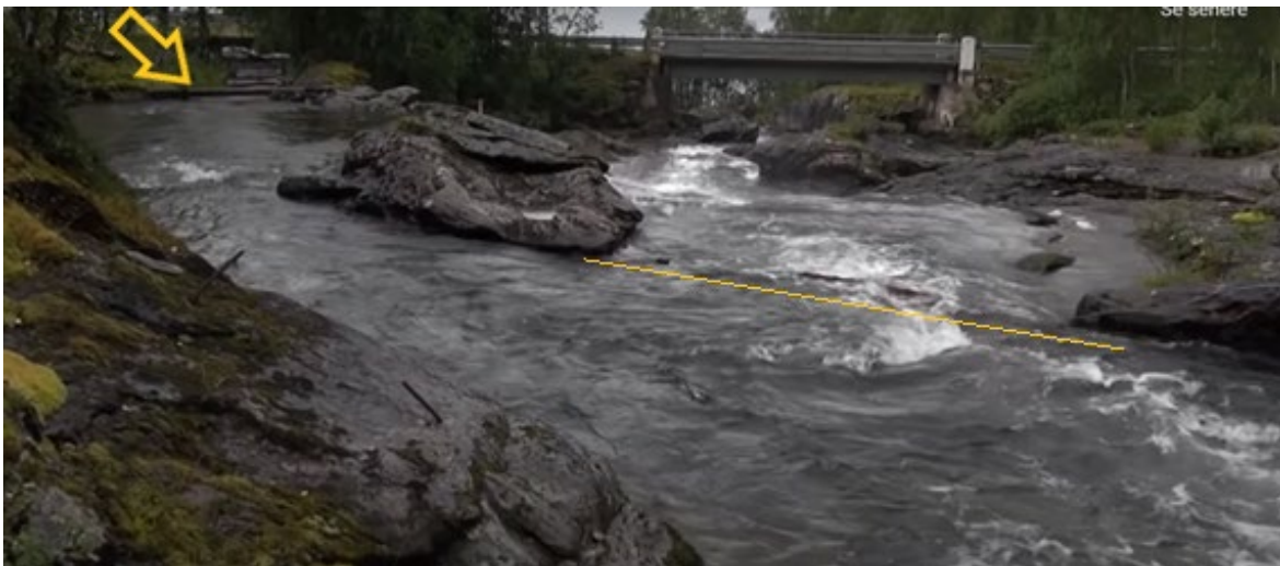
Figur 16 Inntaksdammen på Aursfjordsaga (gul pil). Plassering av damstokk (gul strek). Foto: Skjermdump fra filmen "Aursfjordsaga- enkelt og genialt"
