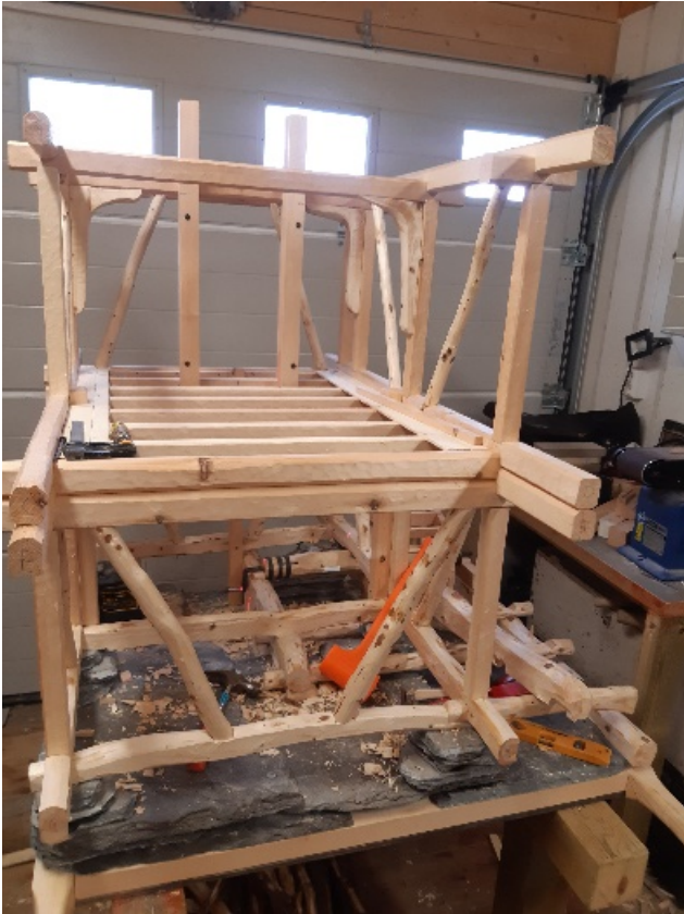
Figur 45 Bærekonstruksjonen på saghuset. Foto: Morten Pedersen
