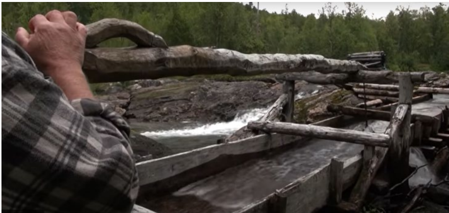
Figur 20 Damluka senkes til nedre posisjon, og vannet begynner å renne nedover i renna. Foto: Skjermdump fra filmen "Aursfjordsaga- enkelt og genialt".
