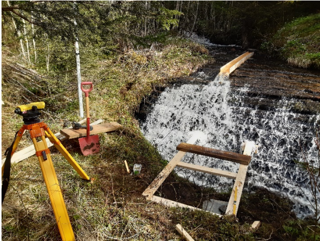
Figur 63 Fundament for modellen rigges til. Foto: Morten Pedersen
