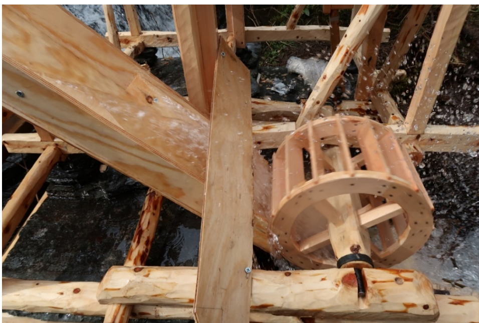
Figur 80 En plate er montert over vannspruten, da treffer alt vannet skovlene. Foto: Morten Pedersen
