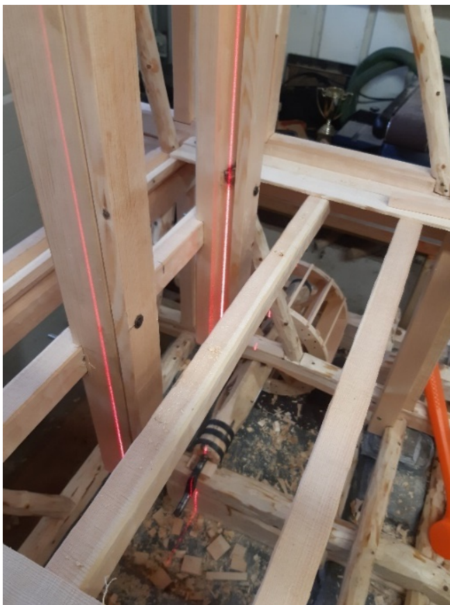
Figur 59 Sagramme loddet opp med en laser. Foto: Morten Pedersen
