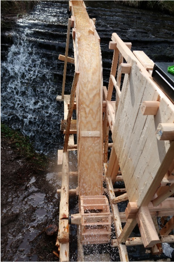
Figur 78 Kiler montert øverst, terskel montert 50 cm fra hjulet. Foto Morten Pedersen
