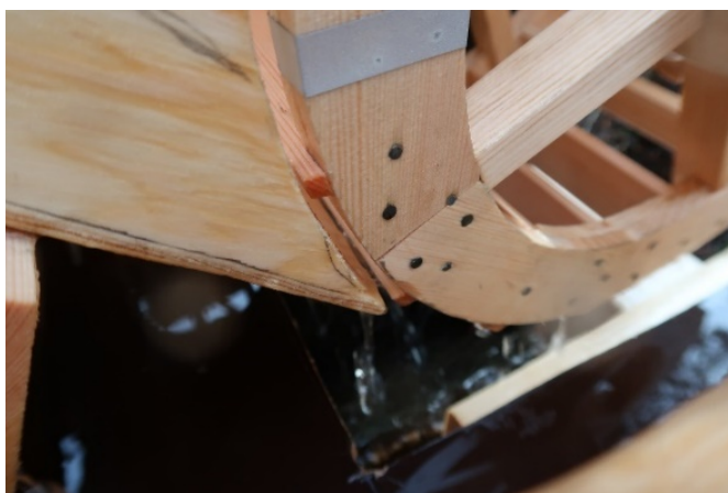
Figur 69 Åpning mellom renne og hjul. Foto: Morten Pedersen
