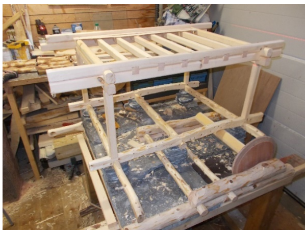
Figur 44 Gulvåsene på plass. Foto: Morten Pedersen
