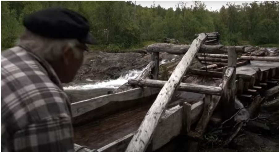
Figur 19 Arne Pedersen gjør klar til å sette vann på Aursfjordsaga, damluka i øvre posisjon. Foto: Skjermdump fra filmen "Aursfjordsaga- enkelt og genialt"
