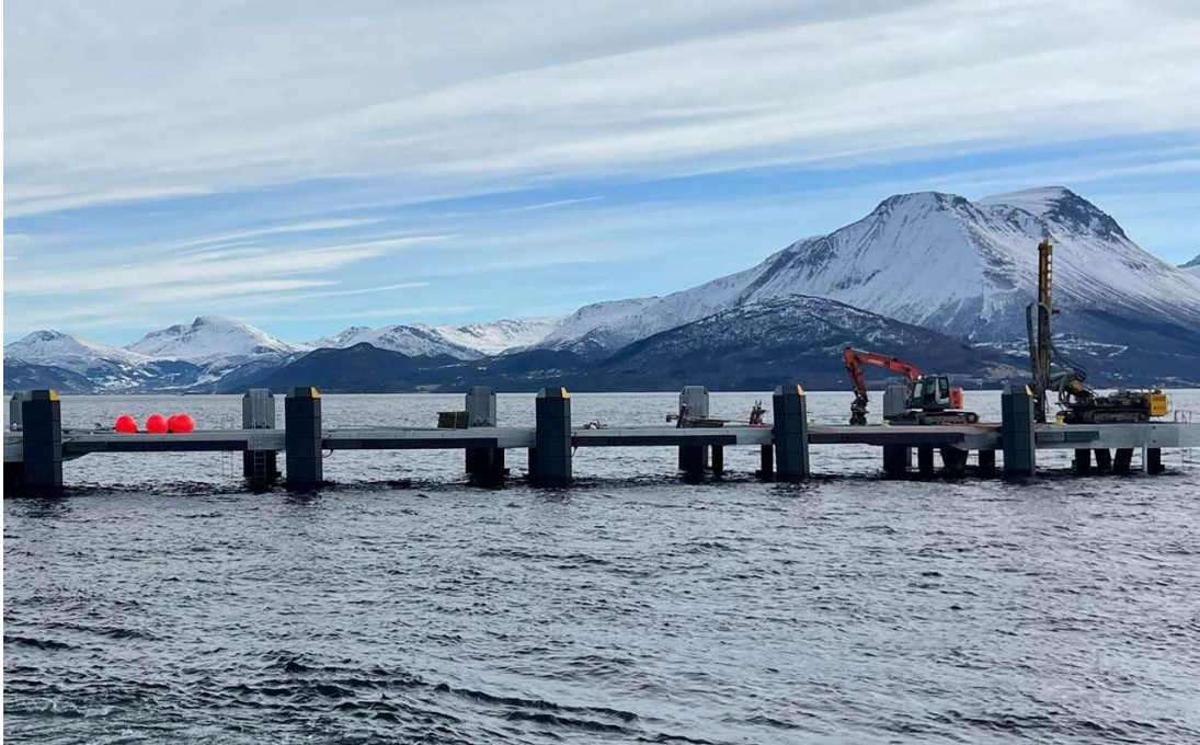
Figur 31: Fra befarings på Solavågen fergekai 09.03.2022. Foto: Christoffer A. Stene Berg.
