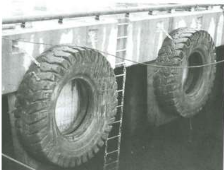
Figur 6: Eksempel på fenderverk av dumperdekk på kaikonstruksjon. Kilde: [14].
