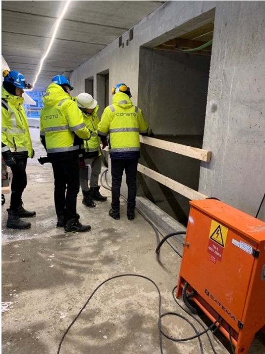
Figur 3: Befaring med XTM og Consto Nord AS
