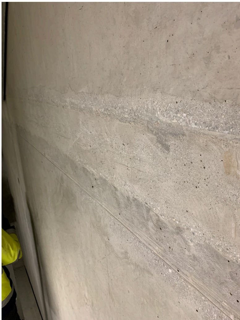
Figur 21: Utført skjøtestøp på Pynten
