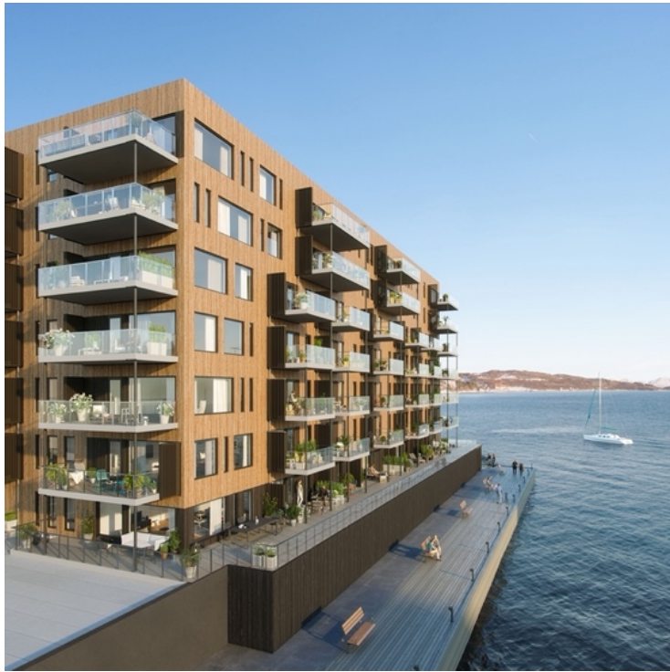
Figur 1: Østlig fasade på Pynten
