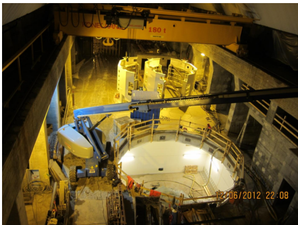
Figur 4: Maskinsal under konstruksjon, [4]
