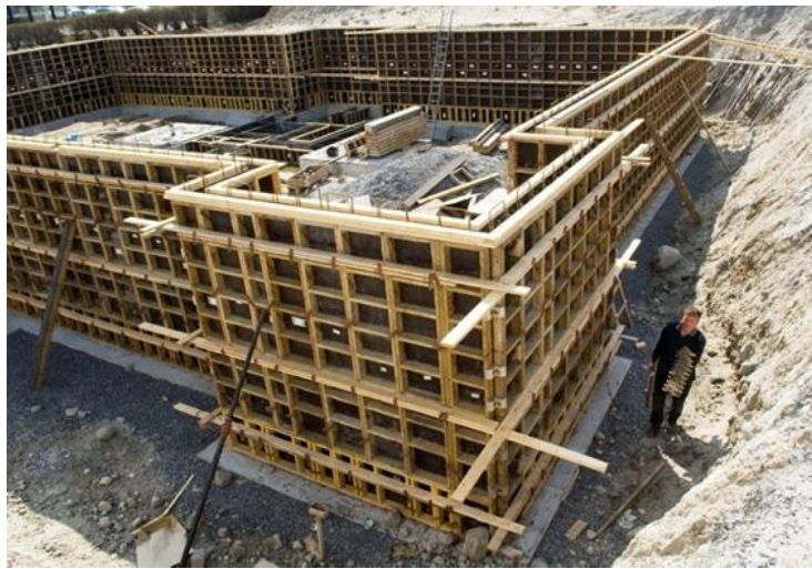
Figur 3: Veggforskaling på byggeplass. Foto: algeco.no
