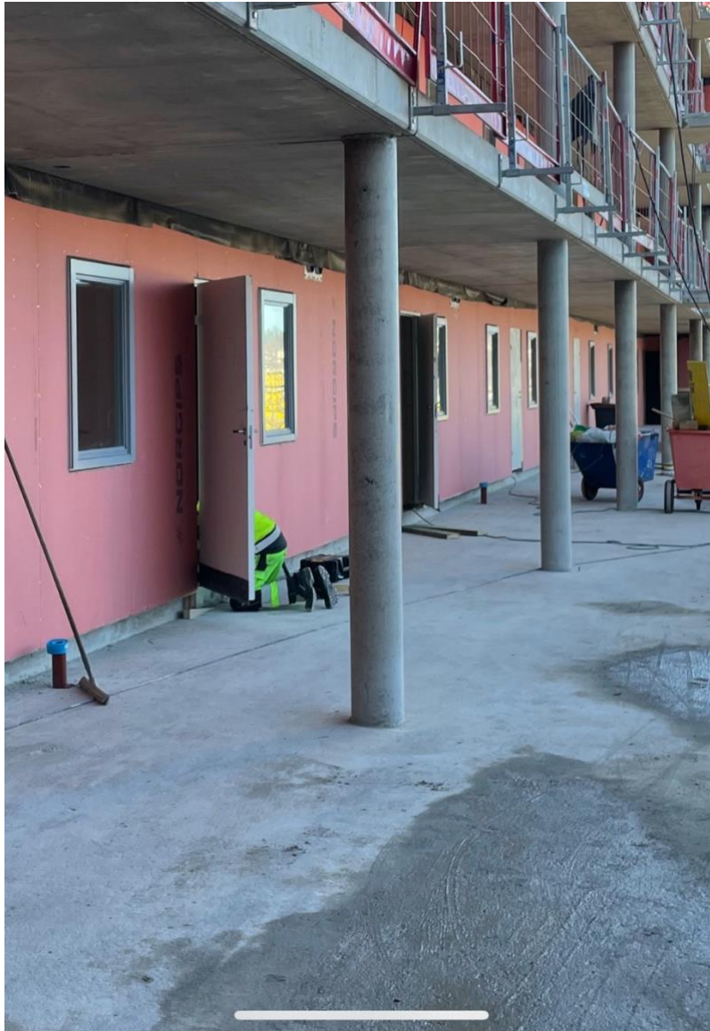
Figur 8: Sirkulær søyle på byggeplass i Steinkjer. Foto: Ina Kjelland
