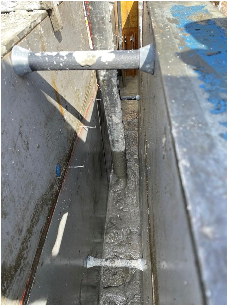
Figur 25. Støp basaltvegg. Foto: Mats Brastad
