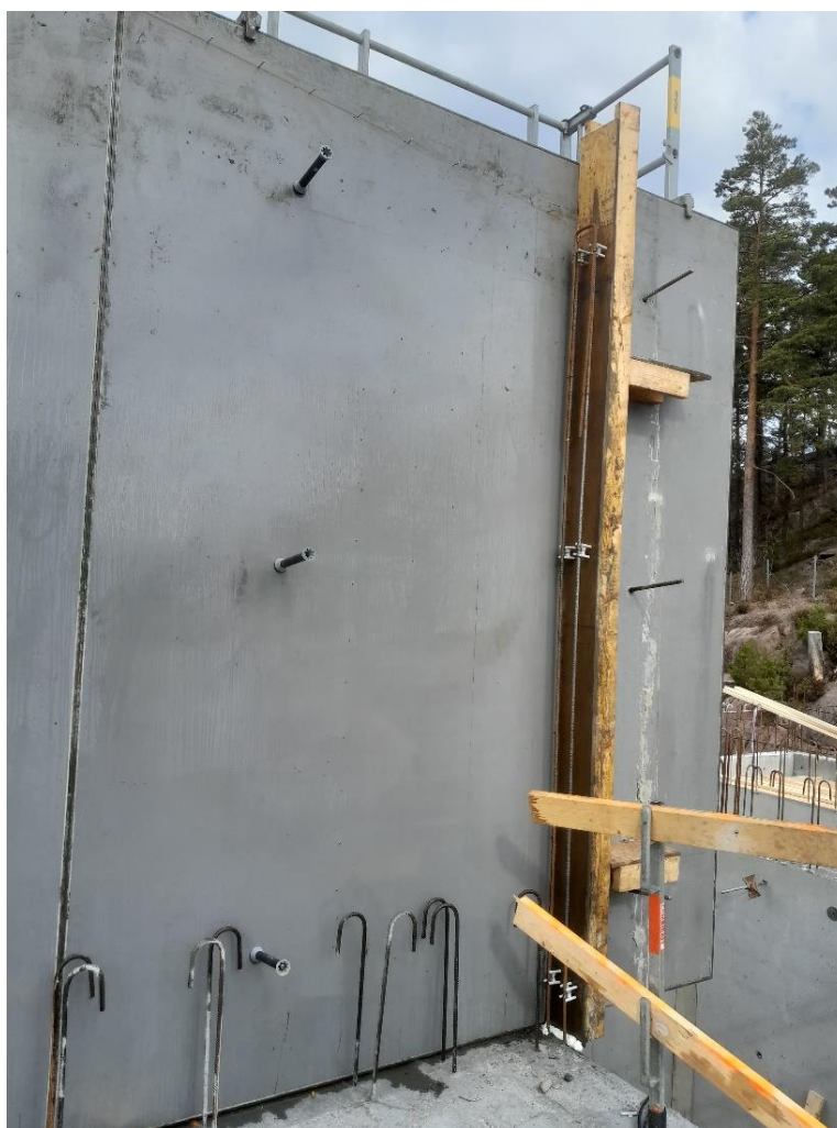
Figur 21. Tradisjonell armering i basaltvegg. Foto: Kevin Bach
