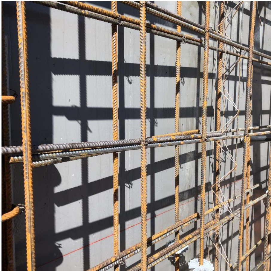
Figur 19. Slakkarmering i tradisjonell vegg. Foto: Kjell Nordli
