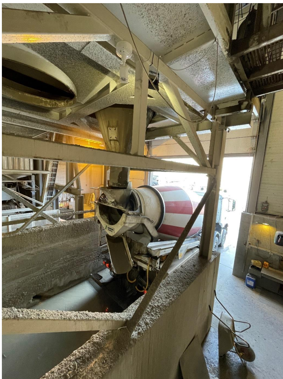
Figur 23. Innblanding og overføring til betongbil. Foto: Mats Brastad
