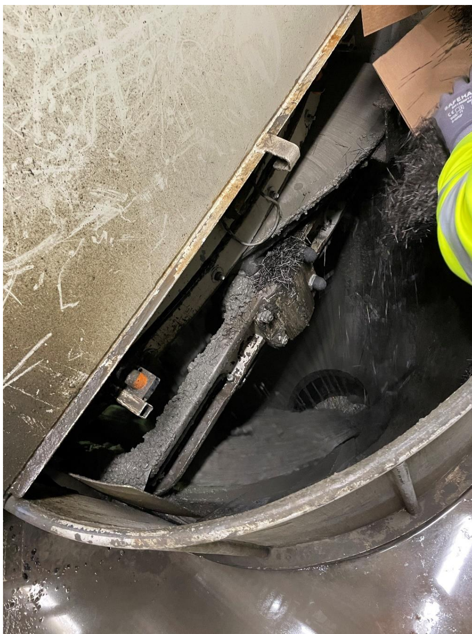
Figur 22. Innblanding av fiber. Foto: Thomas Hille
