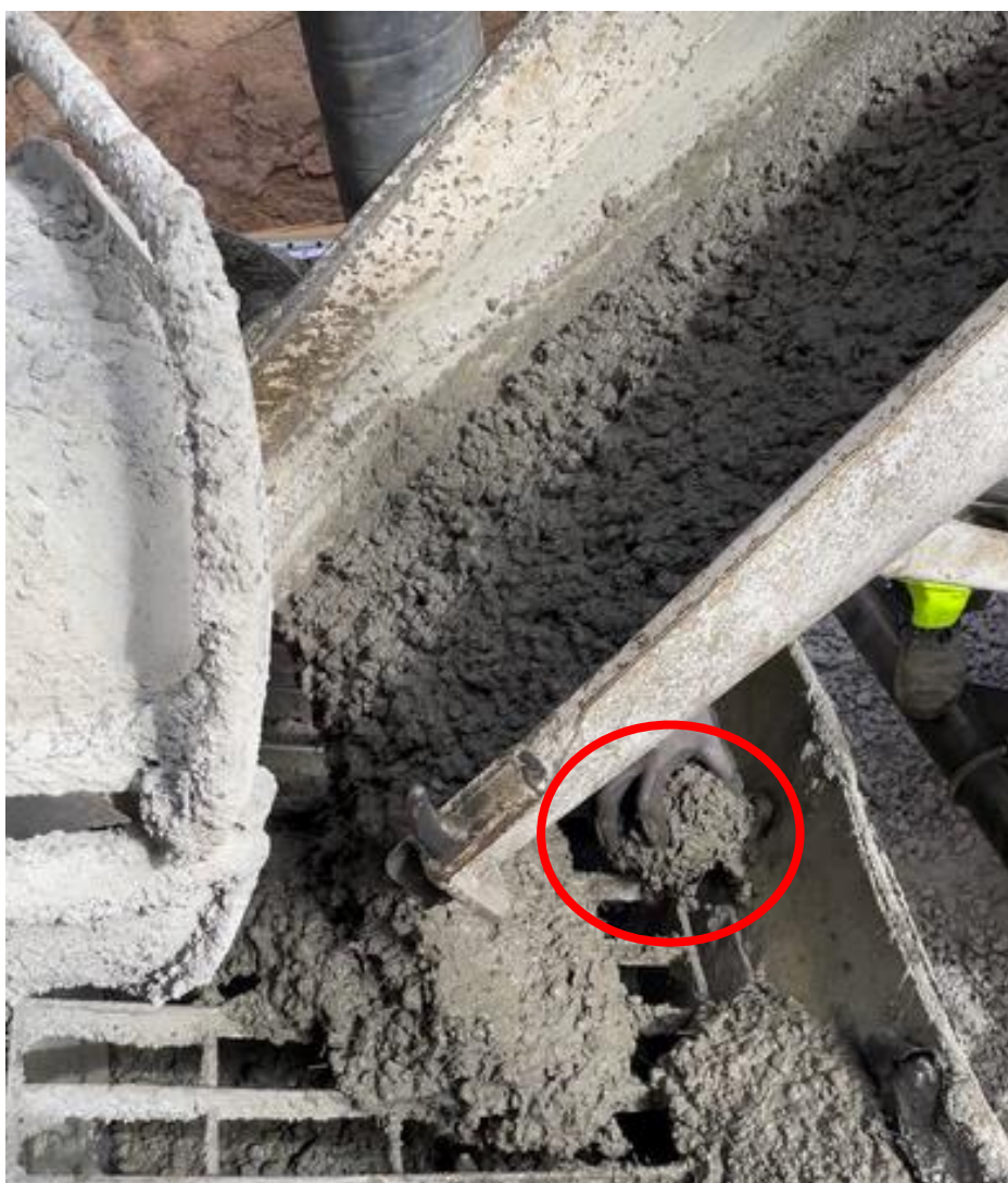
Figur 24. Opphopning av basaltfiber. Foto: Thomas Hille
