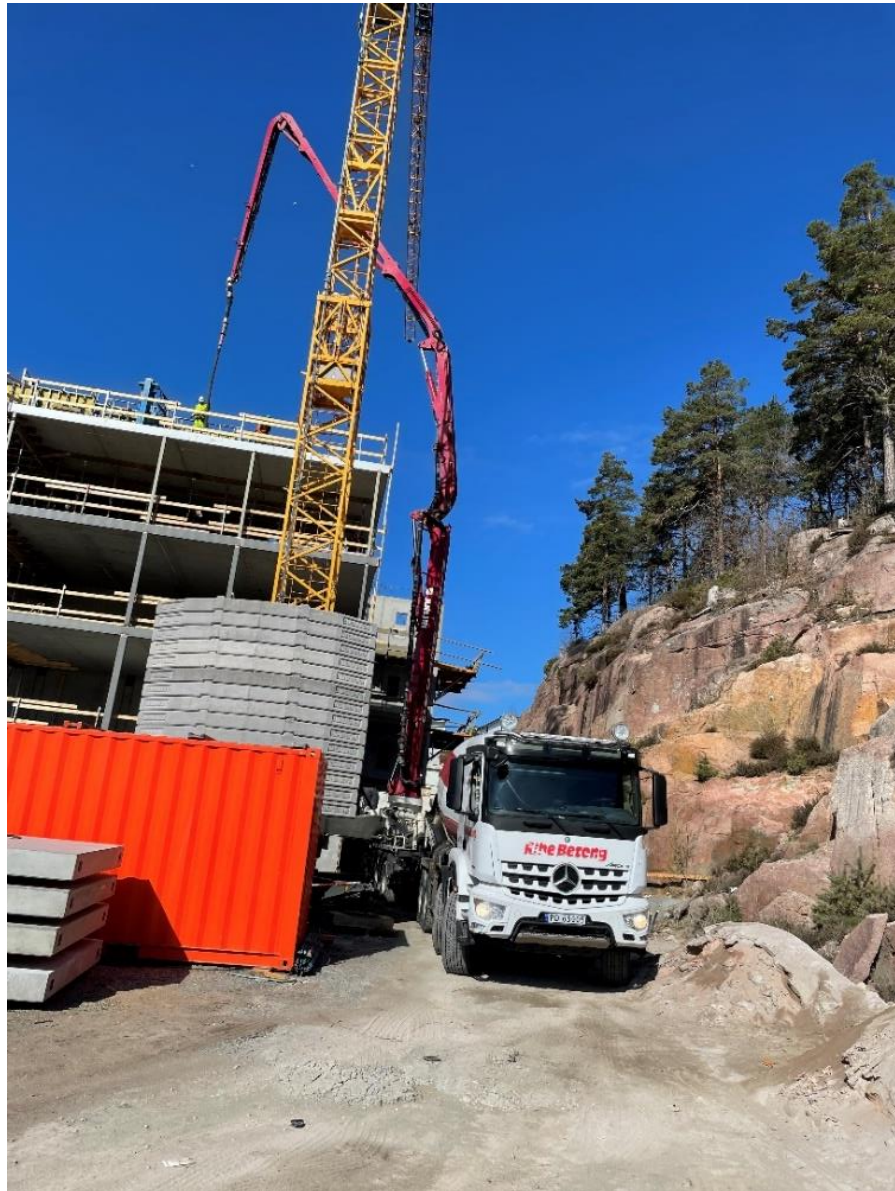
Figur 26. Betong- og pumpebil. Foto: Thomas Hille
