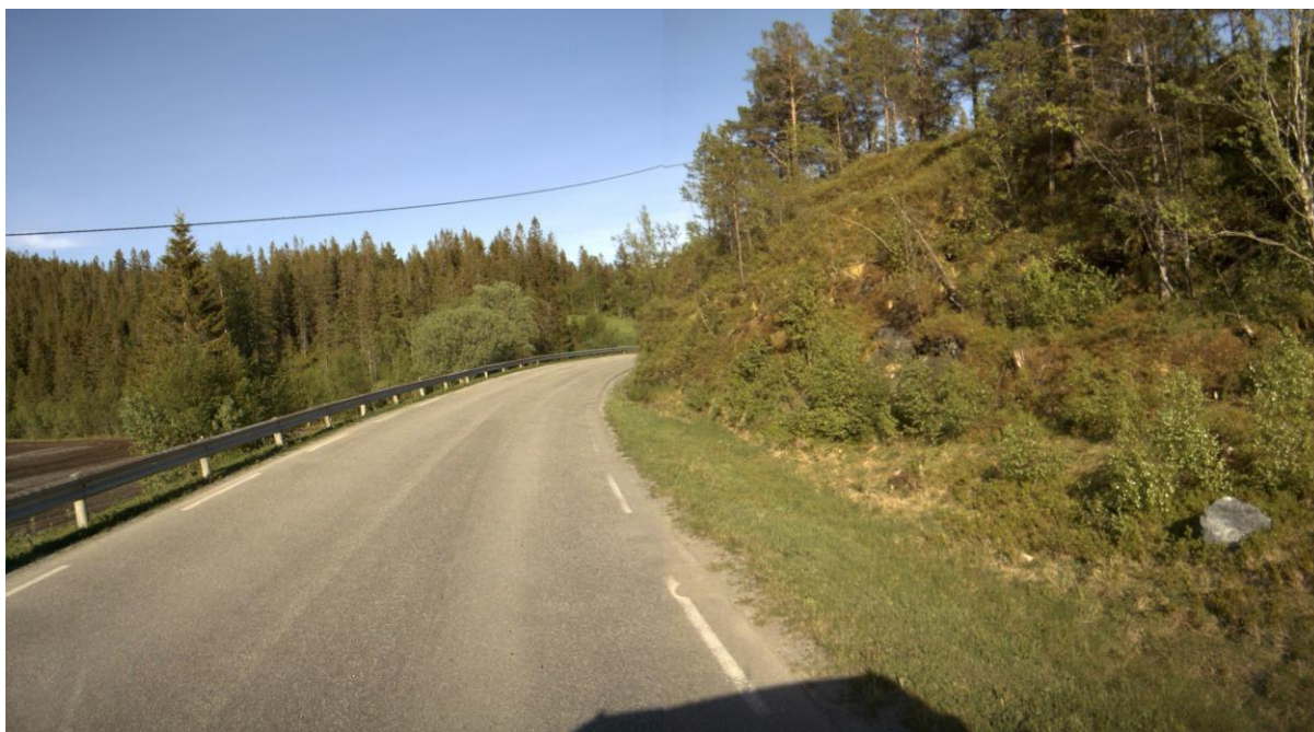
Bilde 4. Bilde som viser sikt gjennom en sving, referansenr. FV6328 S1D1 M5660 F1 (Statens vegvesen, 2021a).
