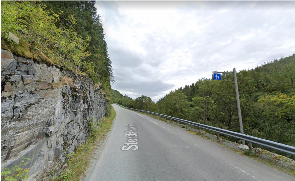
Bilde 15. Bildet viser utvidet vegskulder som løsning for gående og syklende ca. 400 meter fra Årnes sentrum (Google, 2019).
