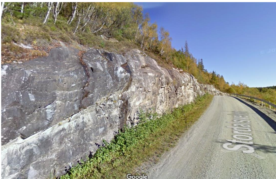
Bilde 6. Bildet viser bergskjæring lokalisert mellom By og Skjern. Skjæringen har en gjennomsnittlig høyde på 5 meter (Google, 2019).
