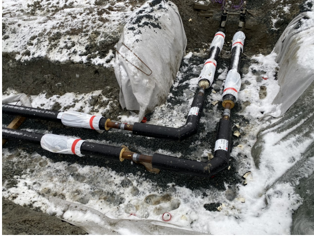
(a) Nylagte tur- og returrør til boligkompleks på Solsletta. (b) Nærbilde av rørskjøt før muffing tatt på Solsletta.
