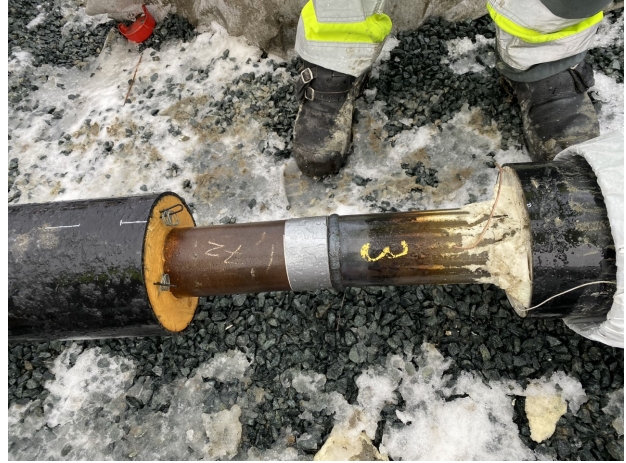
(a) Nylagte tur- og returrør til boligkompleks på Solsletta. (b) Nærbilde av rørskjøt før muffing tatt på Solsletta.
