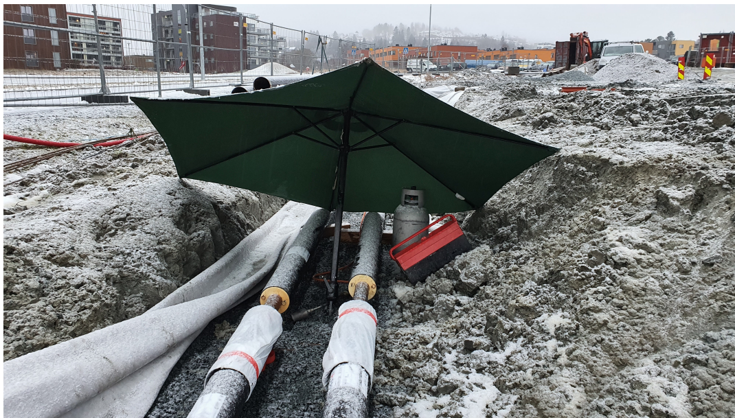
Figur 21: Et eksempel på værbeskyttelse ved installasjon av nye rør og muffe.
