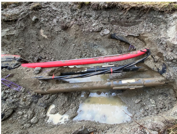
(a) Oppgravd rørskjøt med kilemuffer.
