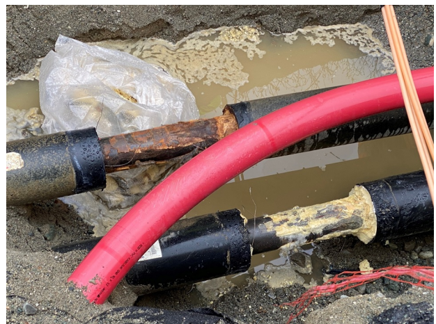
(b) Nærbilde av rørskjøt etter fjerning av muffen.
