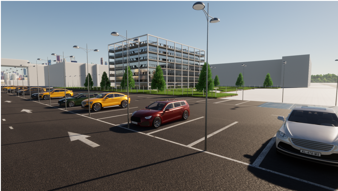
Figur 2: Bygningen sett fra sida
