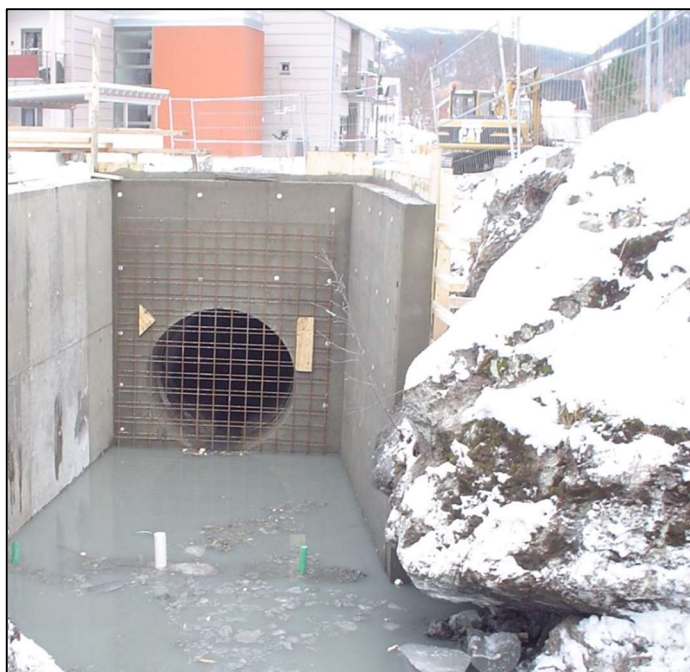
Figur 40 - Bekkeinntak til DN1200 kulvert, Bilde hentet fra Gemini
