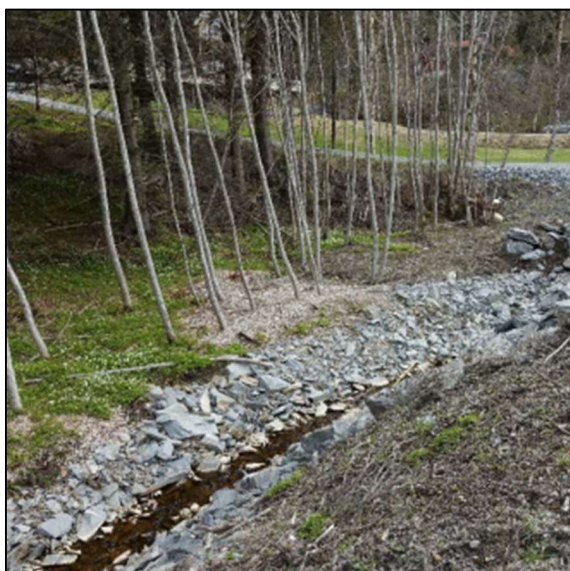
Figur 31 – Eksisterende steinsatt bekkeløp
