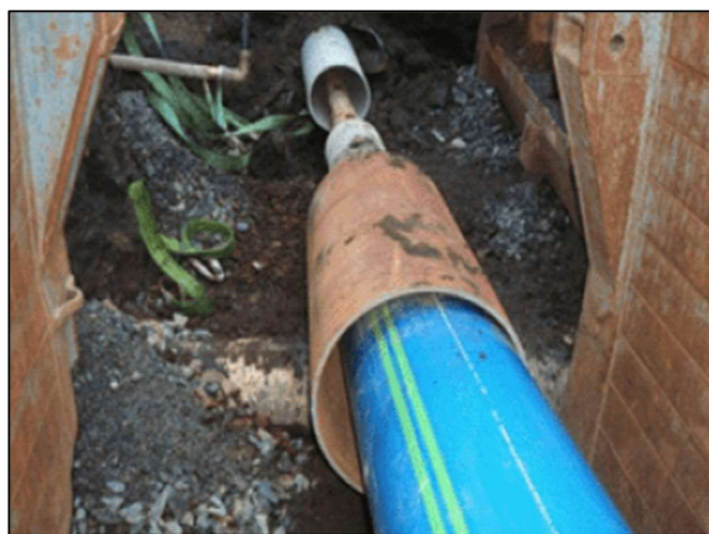
Figur 26 – Oppdimensjonering ved utblokking, figur hentet fra (Olimb AS, 2018)
