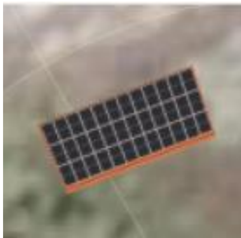
Figur 61 Solcelleinstallasjon på ansattbolig
