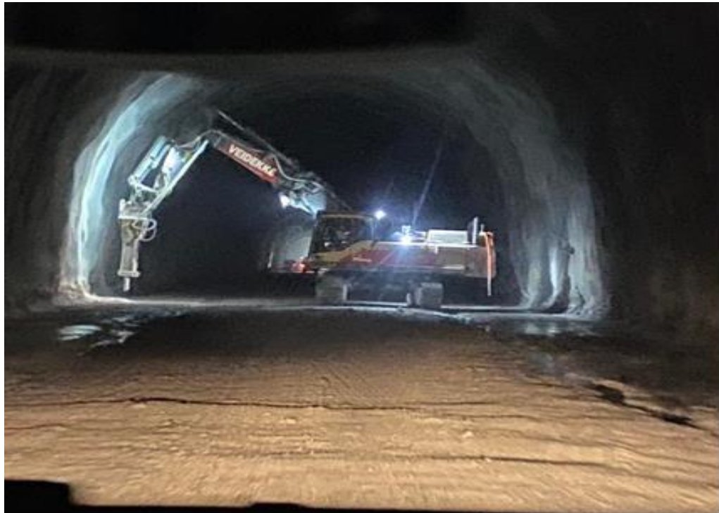
Inne i UDK01 Skogertunnelen, Veidekke er entreprenør på prosjektet.
