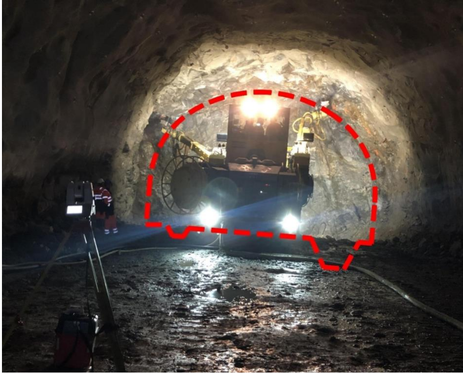
FIGUR 29: TUNNELRIGG I KROKATUNNELEN UNDER BORING AV KONTUR MED ANTYDET TEORETISK SPRENGNINGSPROFIL, I FORGRUNNEN KAN VI SKIMTE LASERSKANNEREN. BILDE OG ILLUSTRASJON: A.N
