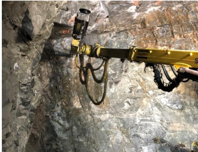
FIGUR 3: BILDE FRA TUNNEL MED EKSEMPEL PÅ UTFALL
