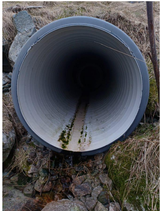
Figur 2: Stikkrenne av plast under Rv13
