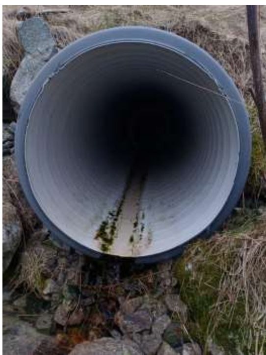
Figur 2: Stikkrenne som krysser riksvegen.
