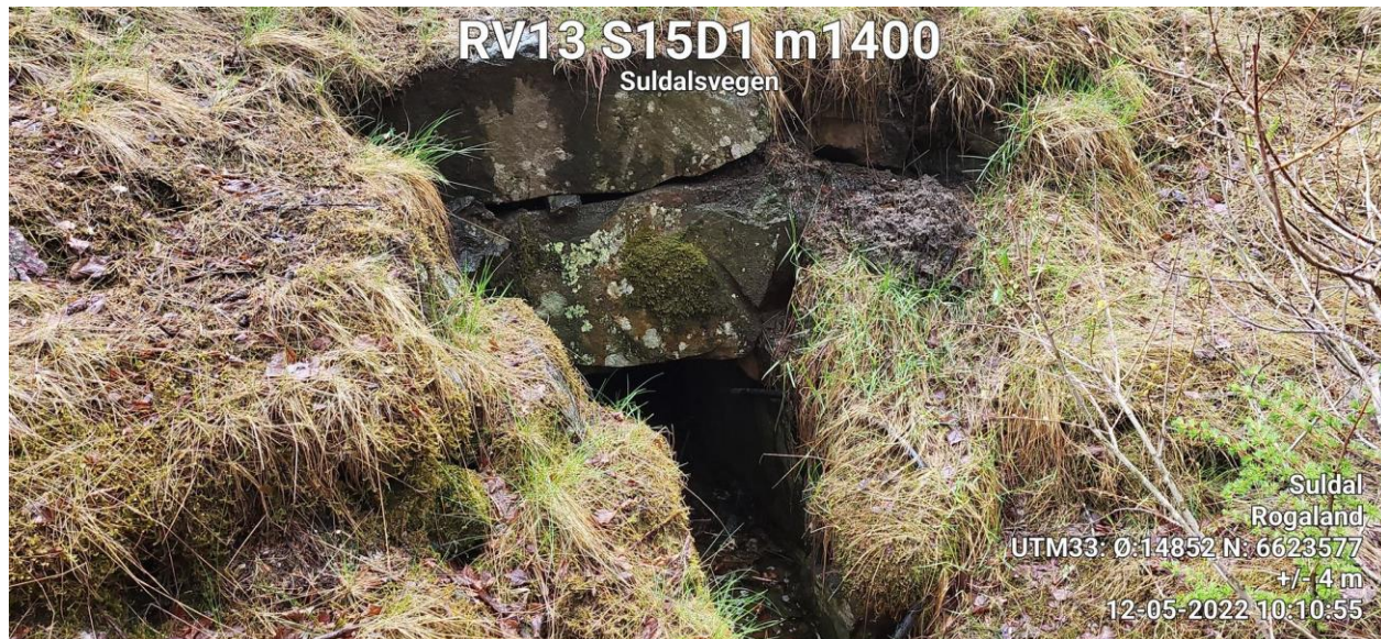
Figur 24: Tørrmur stikkrenne som ble oppdaget under feltundersøkelse.
