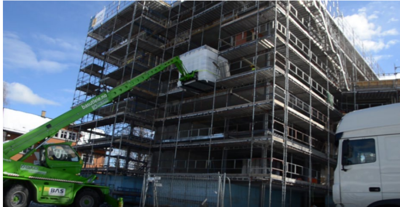
Figur A1. Løfting av våtromsmodul Brødrene Dahl [2].
