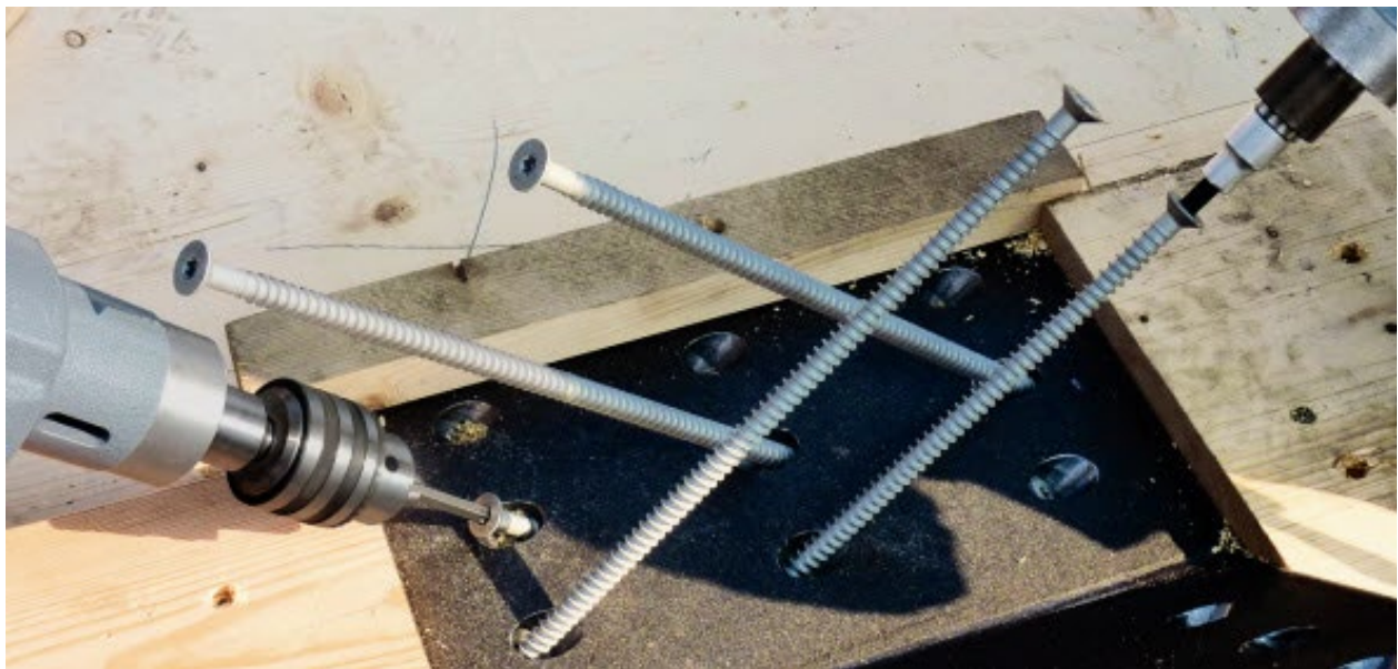
Figur 4.8. Eksempel skruing av vinkelfeste på massivtreelement [42].
