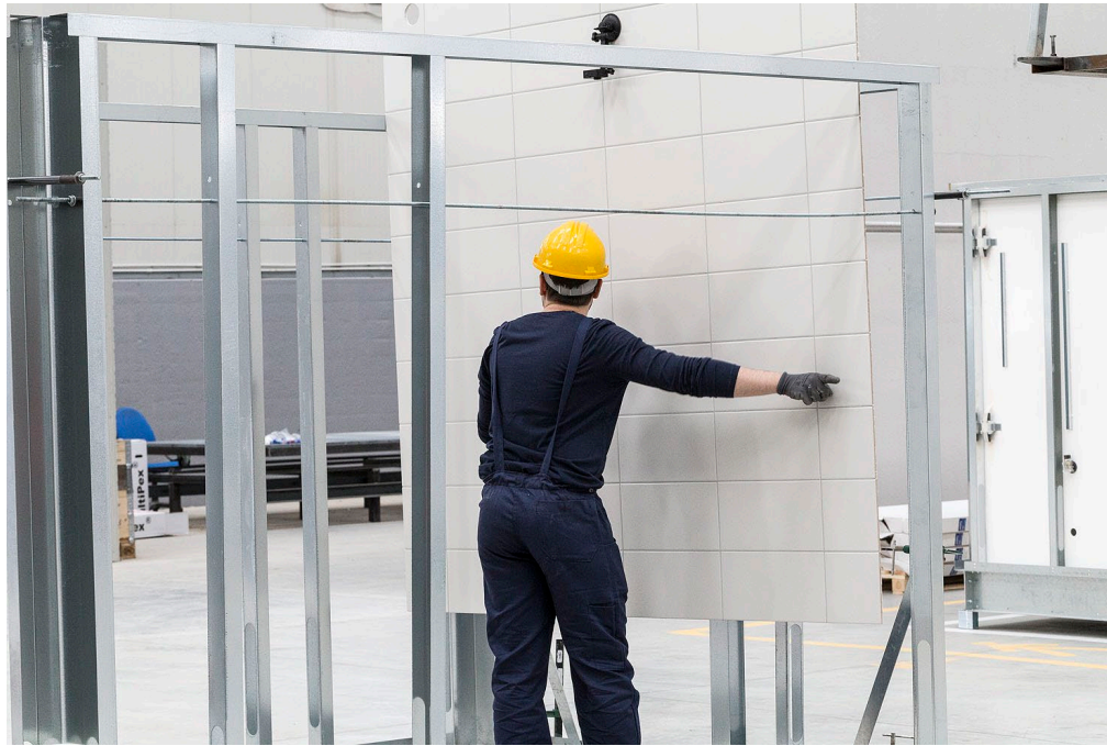
Figur B3. Fabrikkmontering Brødrene Dahl [2].
