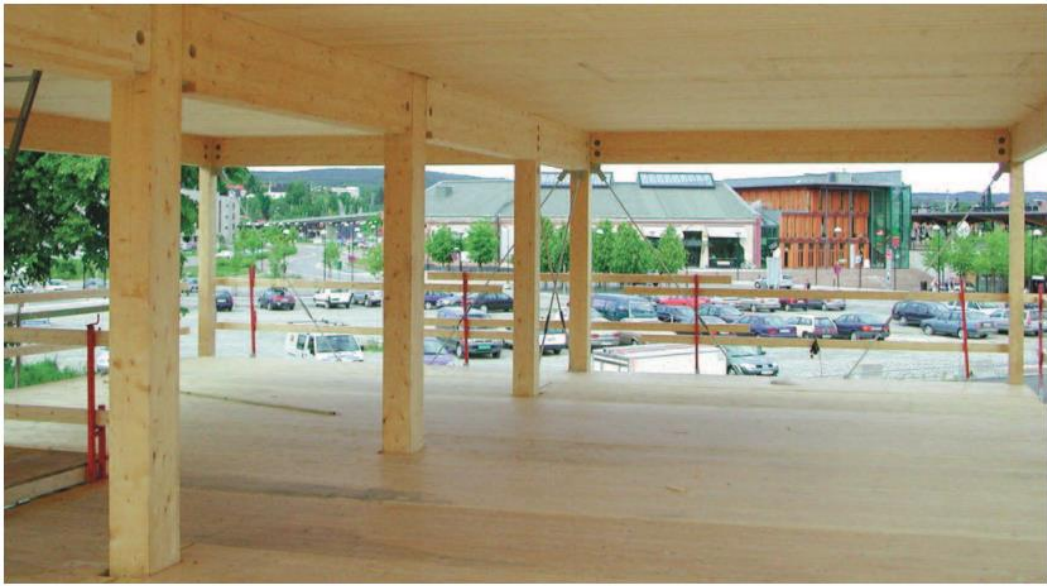
Figur 43 Eksempel på bærende veggssystem kombinert med indre bæring basert på søyler og bjelker: Hentet fra Treteknisk.no
