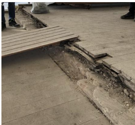
Fig. 65: Påforet tregulv
