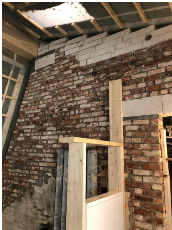
Fig. 14: Hull i takelement tilpasset luftkanalene.
