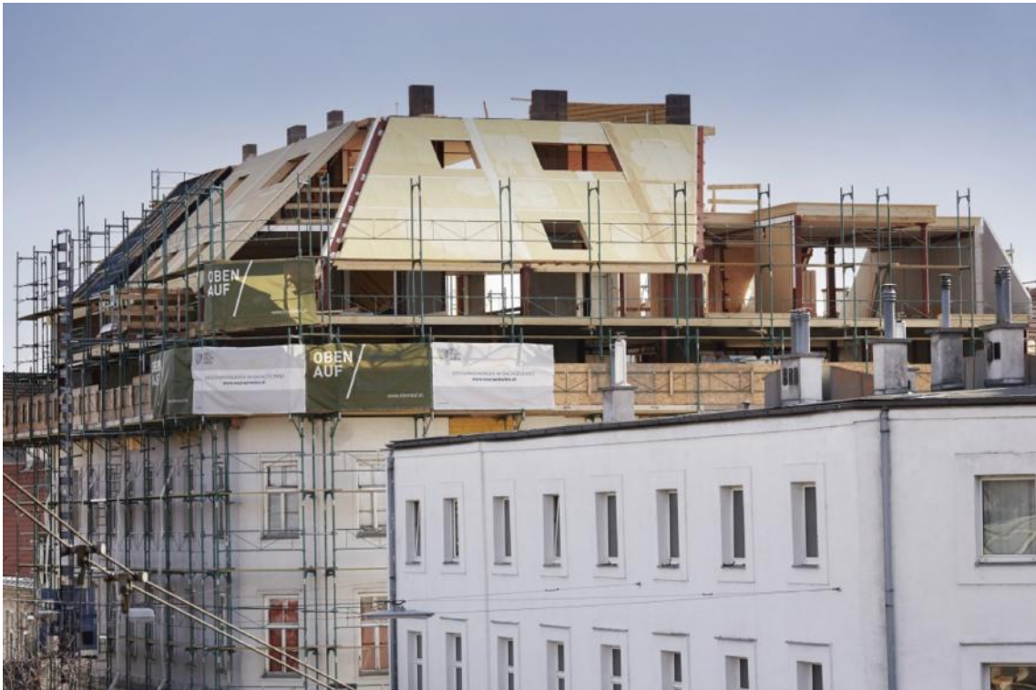
Fig. 81: Påbygg med isolerte treelementer og massivtre i etasjeskillere: Grangasse i Wien. Foto: OBENAUF
