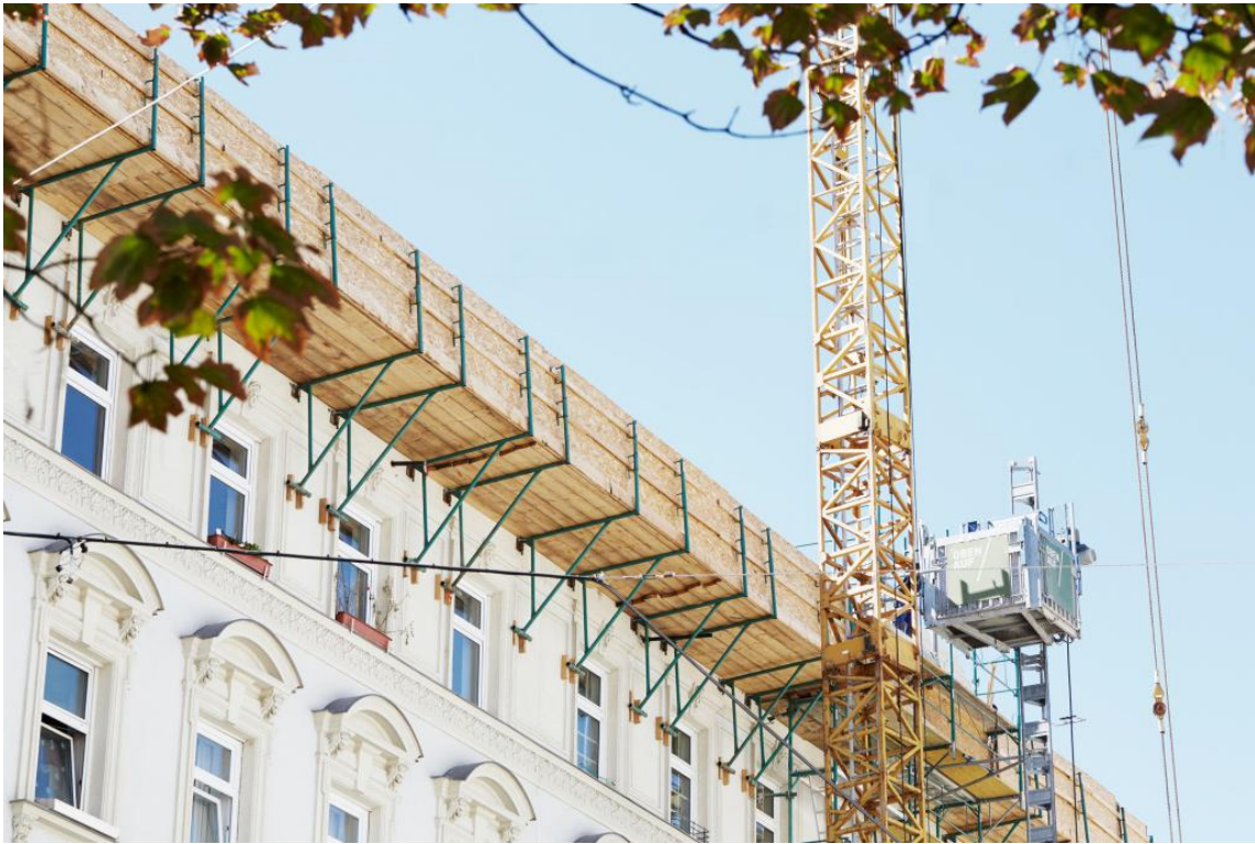
Fig. 87: Sikring rundt bygget monteres etter at taket er revet. Foto: OBENAUF
