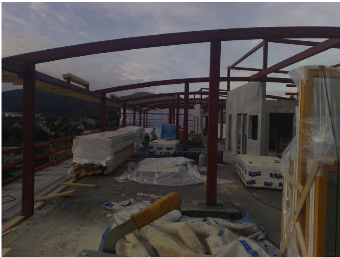
Fig. 78: Bæresystem i stål er montert og protekket mot eksisterende flatt-tak på Barkaleitet borettslag. Foto: Jarl Høve
