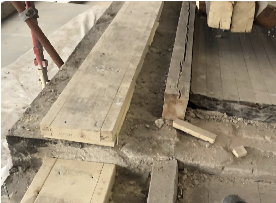
Fig. 68: Tilpasning av styresvill ved trapping
