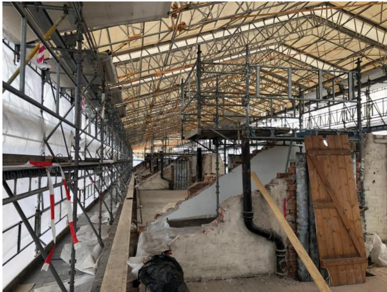
Fig. 6: Status fra Dælenenggata. Elementene er ikke montert.
