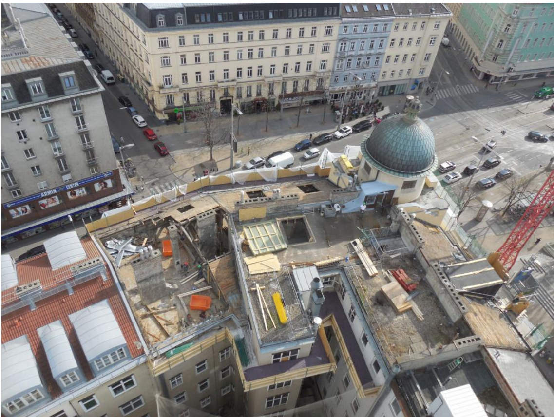
Fig. 88: Fugleperspektiv av et revet loftstak, fra Julius Tandler Platz Foto: OBENAUF
