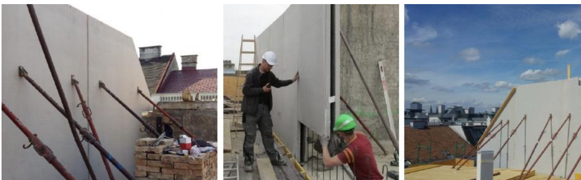
Fig. 90: Montering av brannvegger ved tre forskjellige prosjekter. Foto: OBENAUF.
