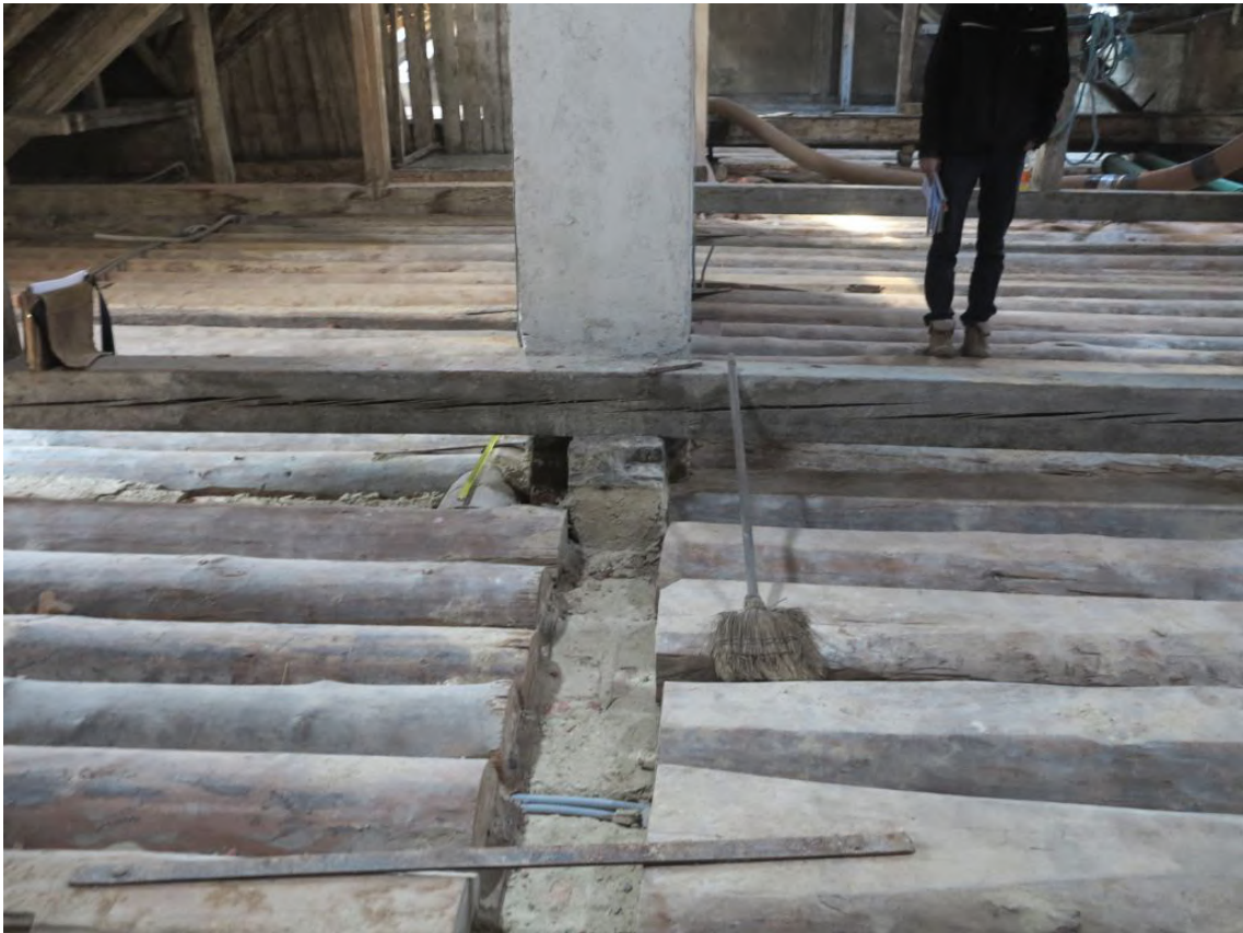
Fig. 85: Trestokk-gulv. Foto: OBENAUF
