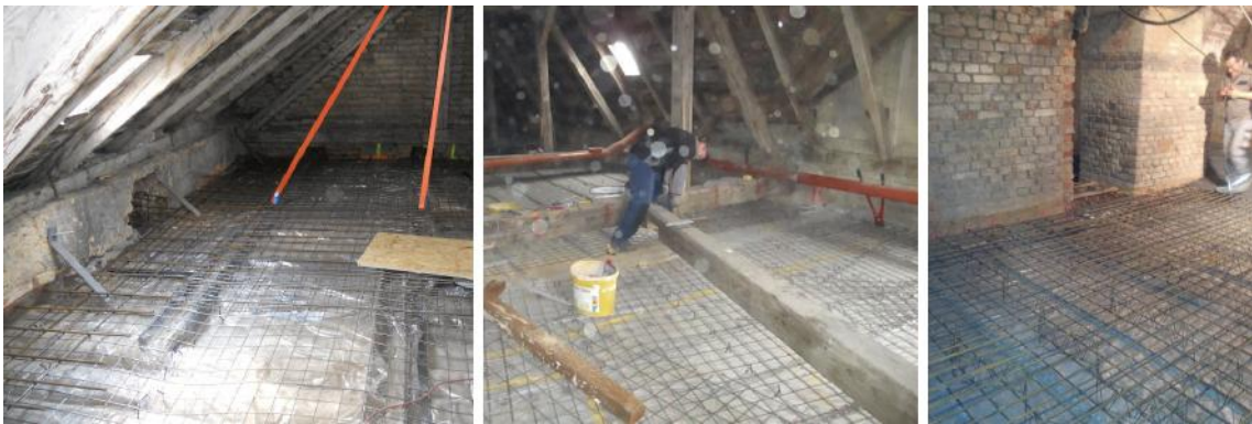
Fig. 86: Armert tregulv. Foto: OBENAUF
