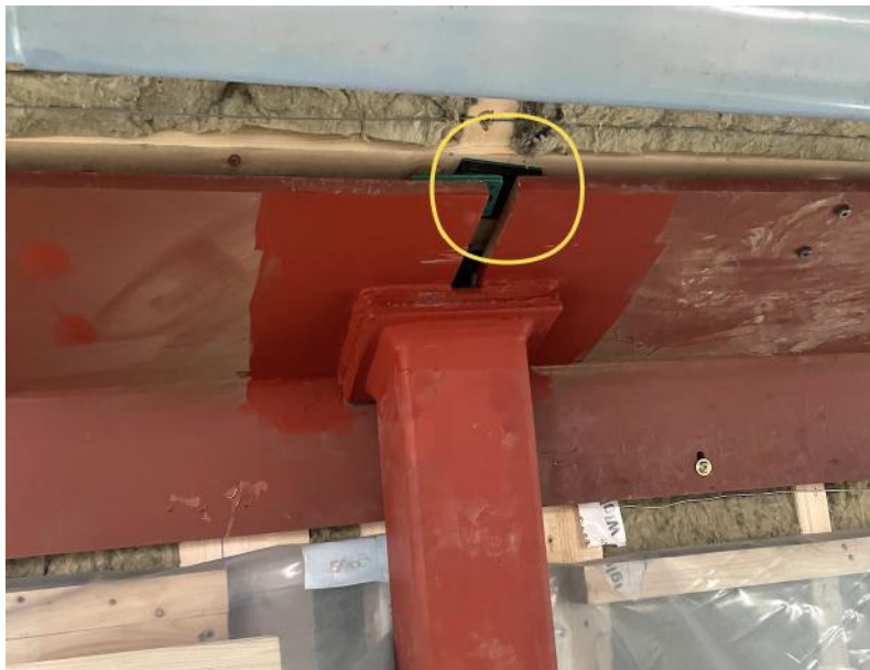
Fig. 57: Sprang mellom flenser rundt søylepunkt
