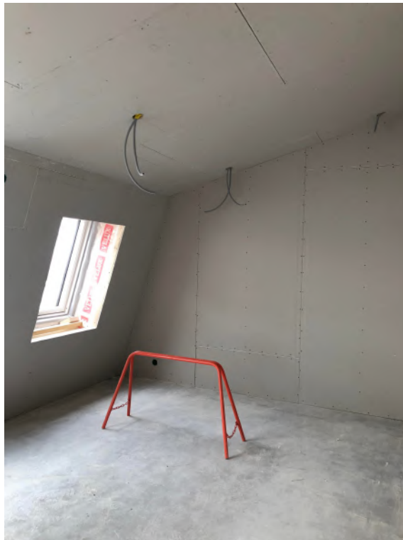
Fig. 4: Status fra Christies gate. Elementene har kledning utvendig.
