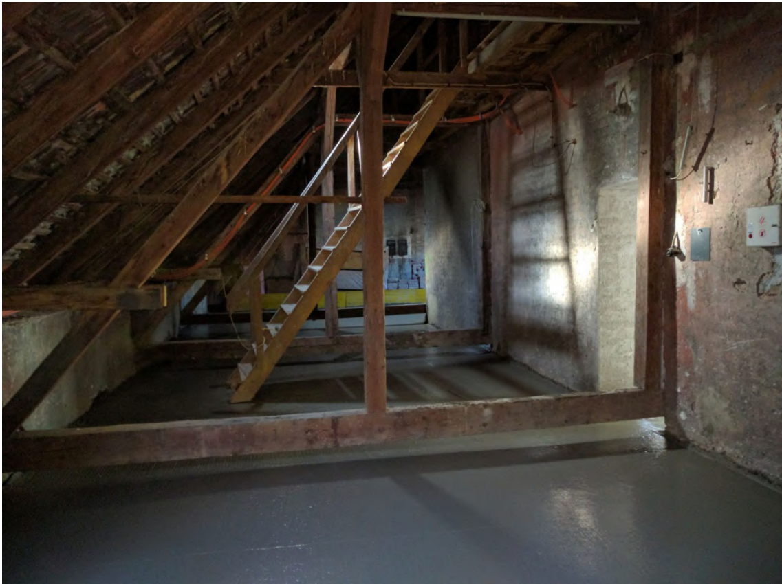
Fig. 84: Knevegg i et eldre bygg. Bilde før taket er revet.
