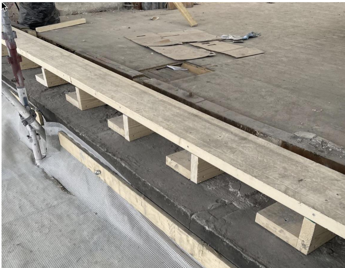
Fig. 66: Justering av svill
