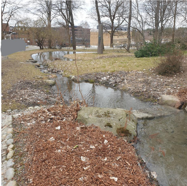
Figur 34: Foto av åpen overvannsløsning nedstrøms (Ved NMBU).
