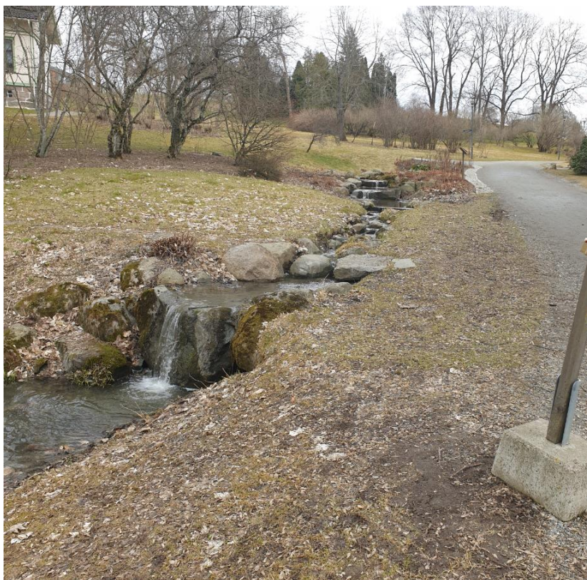
Figur 33: Foto av en åpen overvannsløsning i form av en tersklet bekk (Ved NMBU).
