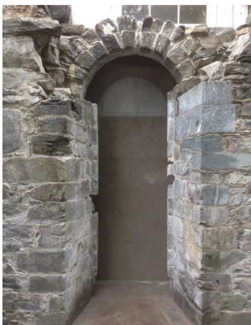
Figur 13 Sørportalen i 2015, etter restaurering. Foto: Geir Magnussen
