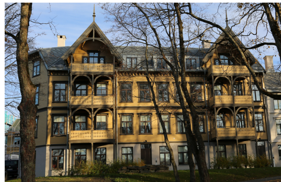
Thingvallagården i Trondheim. De "aktive" og "passive" elementene i fasaden er fargesatt ulikt i tråd med sveitserstilens prinsipper.
